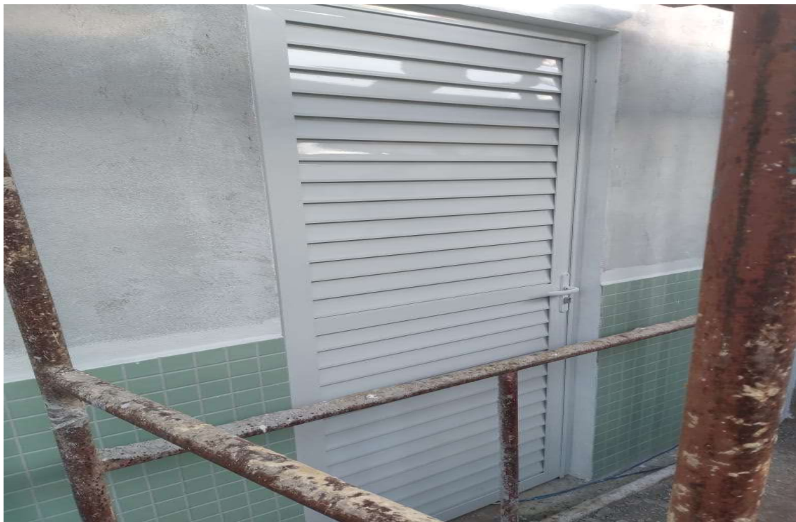
Foto 8: Instalação Porta de Acesso ao Porão;
