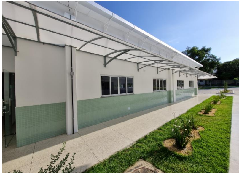
Foto 9: Bloco finalizado - lateral
