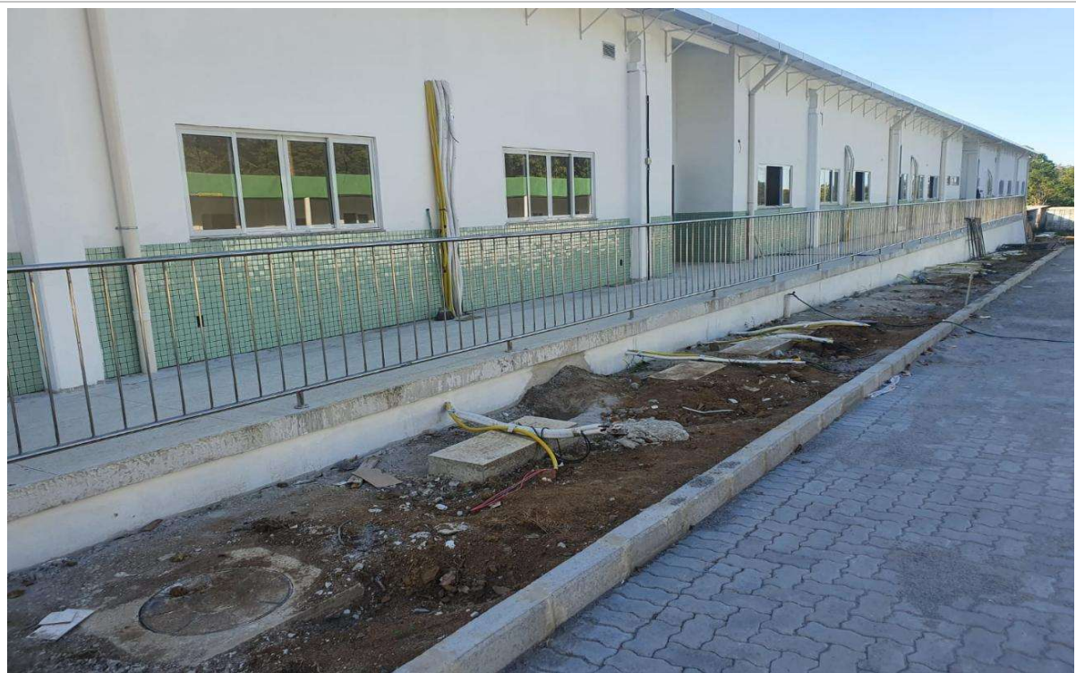
Foto 2: Instalação de Revestimento Externo, Parede sob a laje suspensa e Guarda Corpo;
