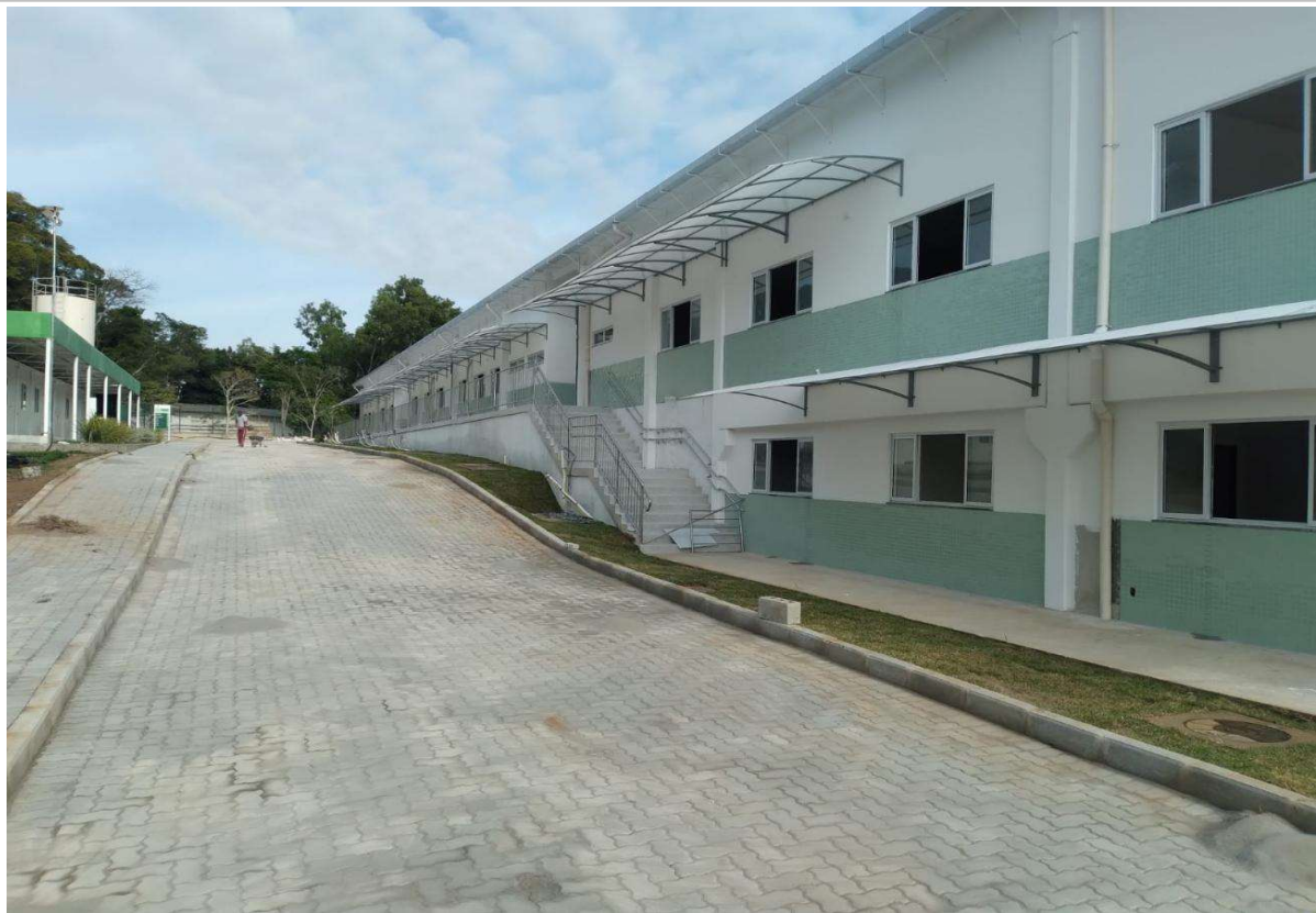
Foto 1: Instalação toldos, guarda corpo e corrimão em inox e de Revestimento Externo;
