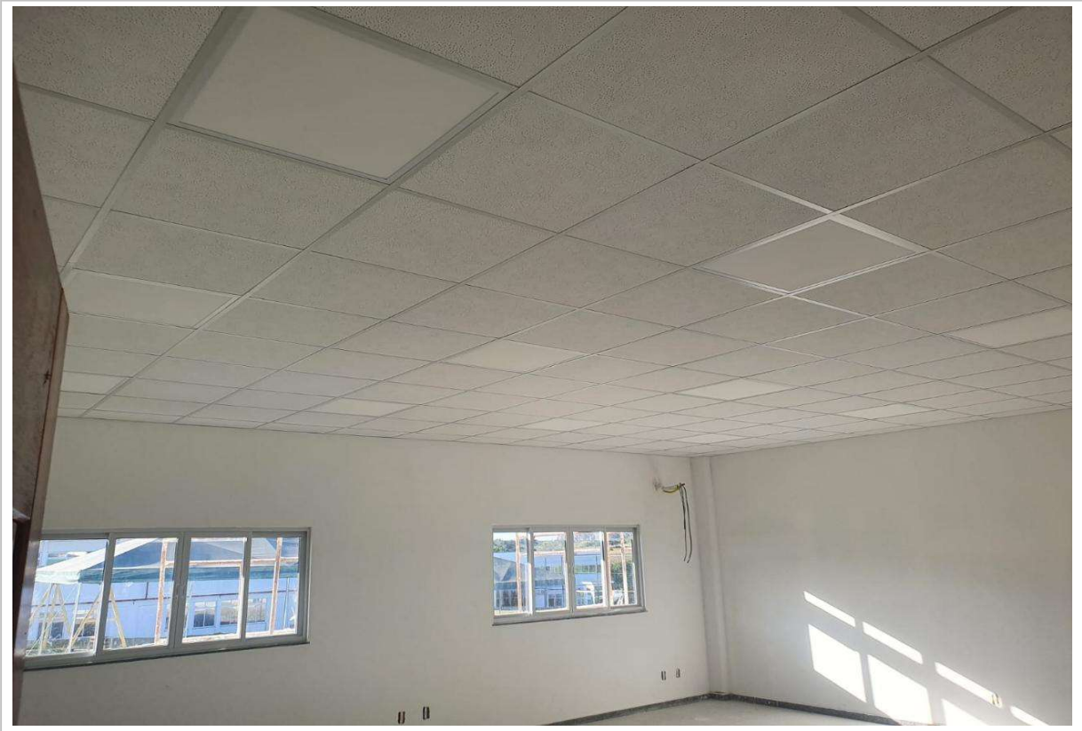
Foto 5: Instalação Forro e luminárias;
