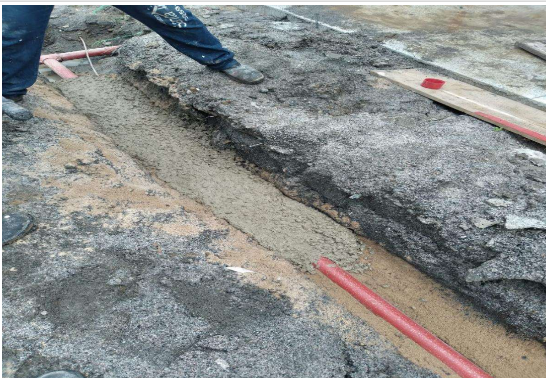
Foto 18: Item 19: Instalações de Combate a Incêndio;
