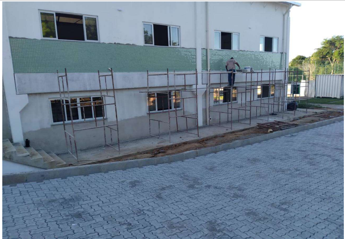
Foto 1: Instalação de Revestimento Externo;
