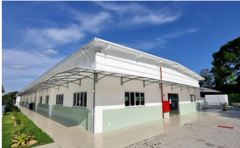
Foto 1: Bloco finalizado - frente
