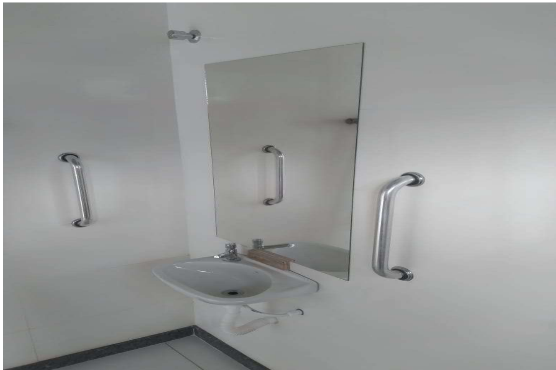
Foto 2: Instalação de Espelhos;
