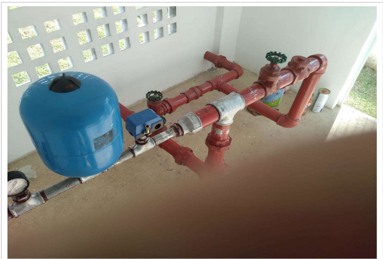
Foto 4: Instalação Kit Hidropneumático;
