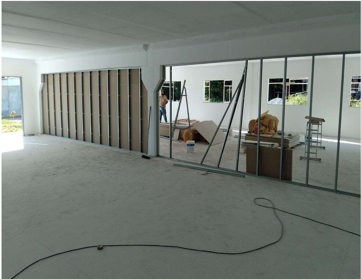
Foto 1: Item 5.2.1: Paredes em Dry Wall: Depósito;
