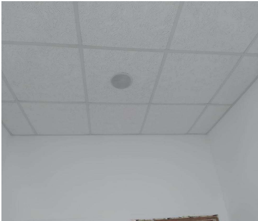
Foto 7: Instalação sistema de som;
