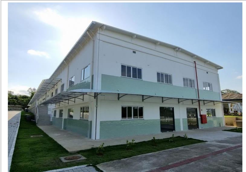
Foto 4: Bloco finalizado - fundos
