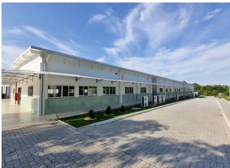
Foto 3: Bloco finalizado - lateral
