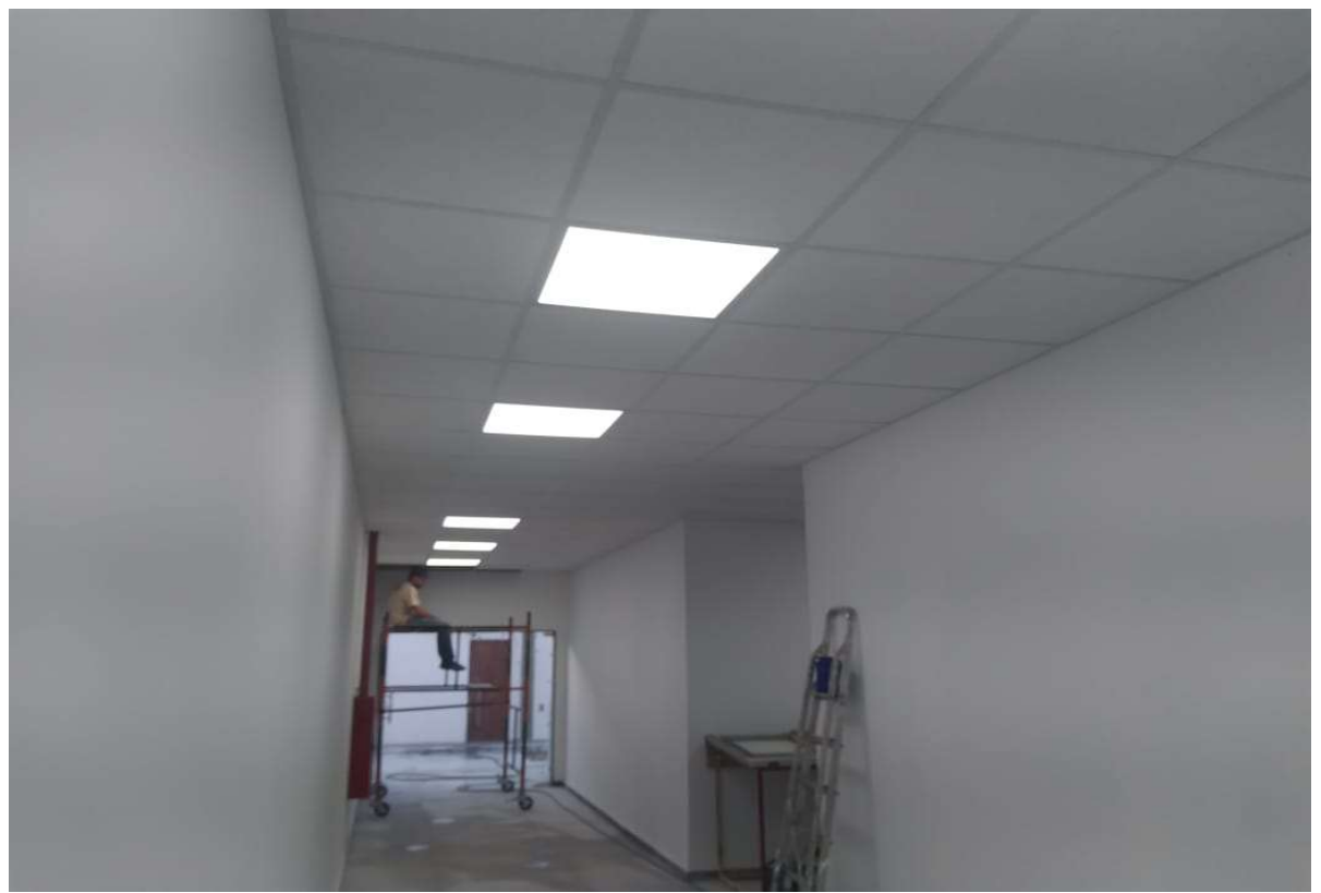
Foto 5: Instalação Forro e luminárias;
