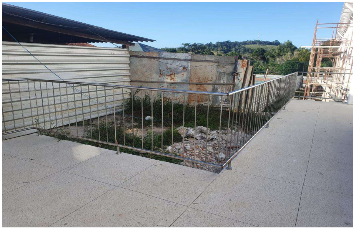
Foto 3: Instalação do Guarda Corpo
