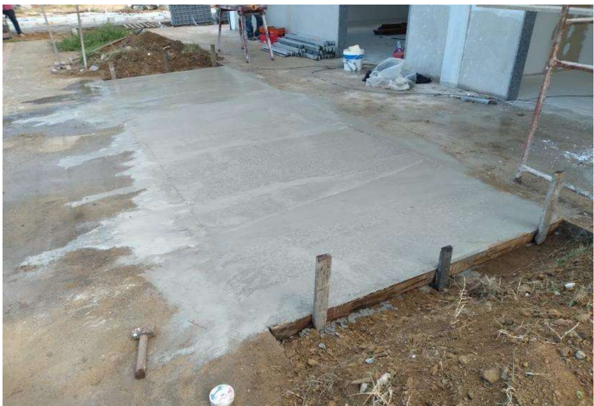
Foto 6: Ligação Bloco F e Quadra;
