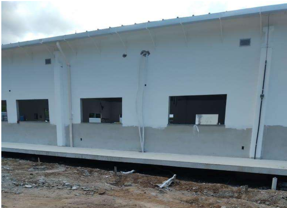
Foto 9: Item 14.12.1: Tubos descida pluvial;
