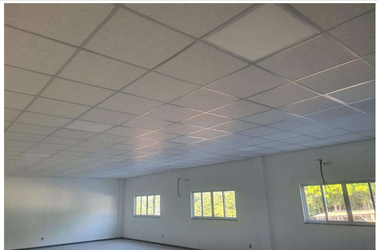
Foto 4: Instalação Forro e luminárias;
