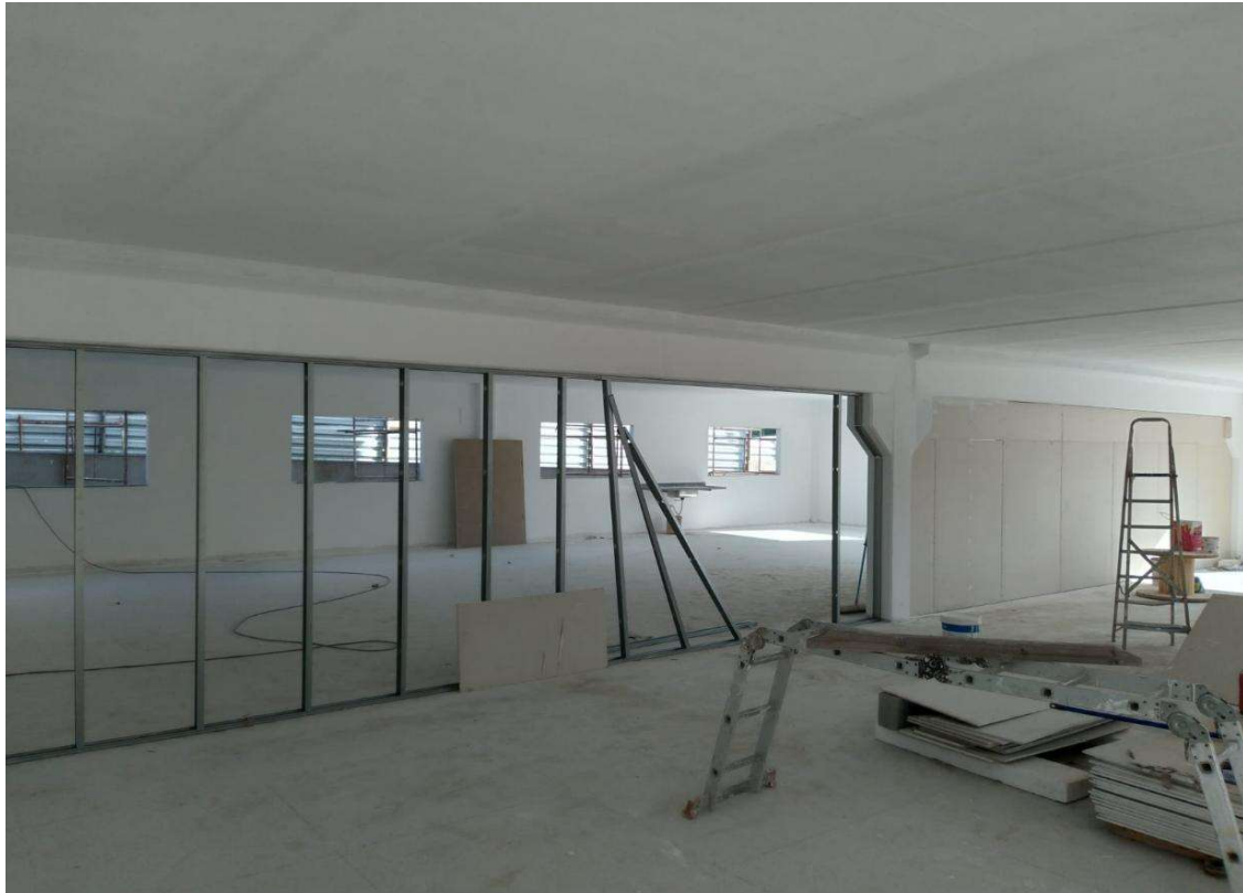
Foto 5: Revestimento no teto do Depósito;
