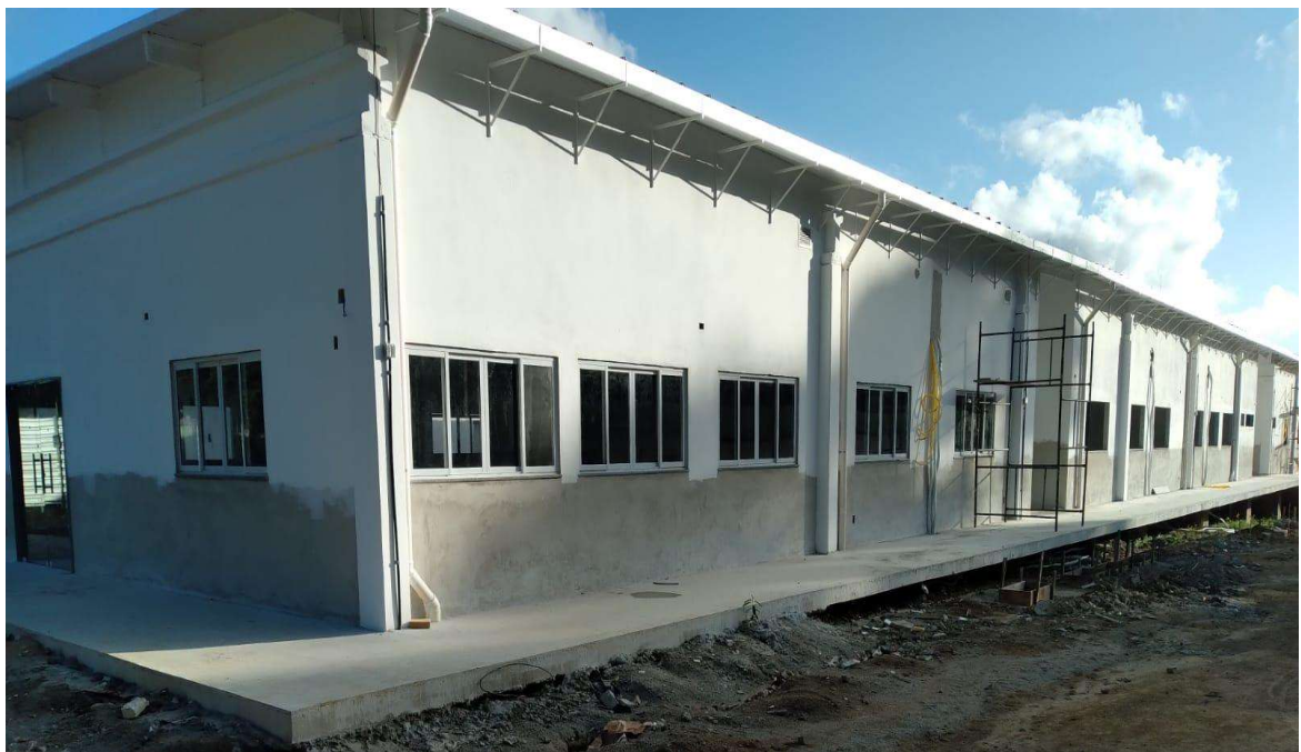
Foto 2: Item 7.2.3: Janelas em Alumínio;
