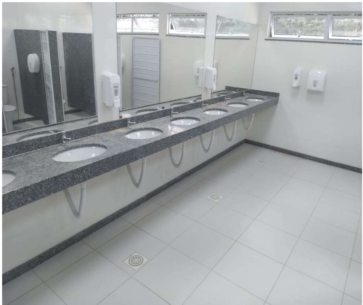
Foto 9: Instalação espelhos e acessórios de banheiro;
