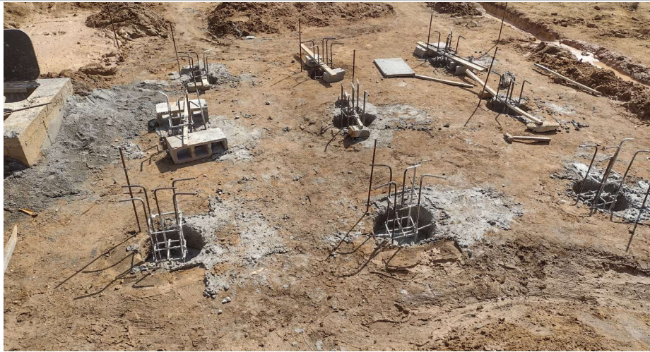
Foto 14: Armadura e Concretagem Estaca Broca;
