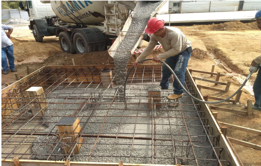
Foto 16: Armadura, fôrma e concretagem bloco de apoio do reservatório;
