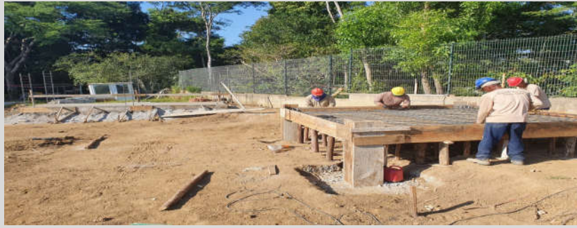
Foto 8: Itens 3.2.1 e 3.2.2: Escavação e Reaterro das Fundações Reservatórios e Casa de Bombas ;
