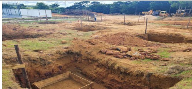
Foto 14: Item 3.2.1: Escavação mecânica
