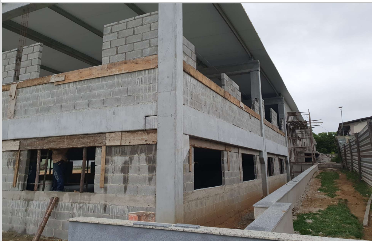
Foto 1: Item 5.1.1: Alvenaria; Item 5.3: Verga e Contraverga; Item 12.2.2: Chapisco
