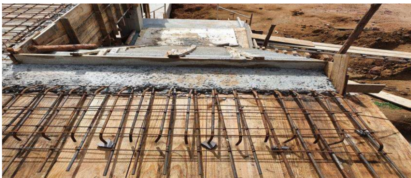
Foto 7: Itens 4.1.16 a 4.1.19: Aramadura da escada;
