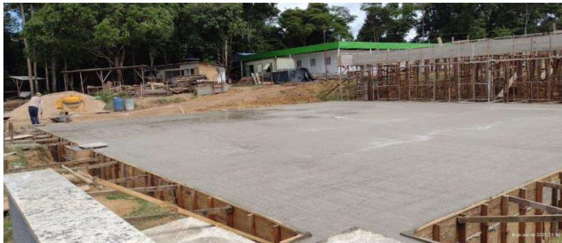
Foto 3: Item 4.1.3: Concretagem do Radier do Depósito;
