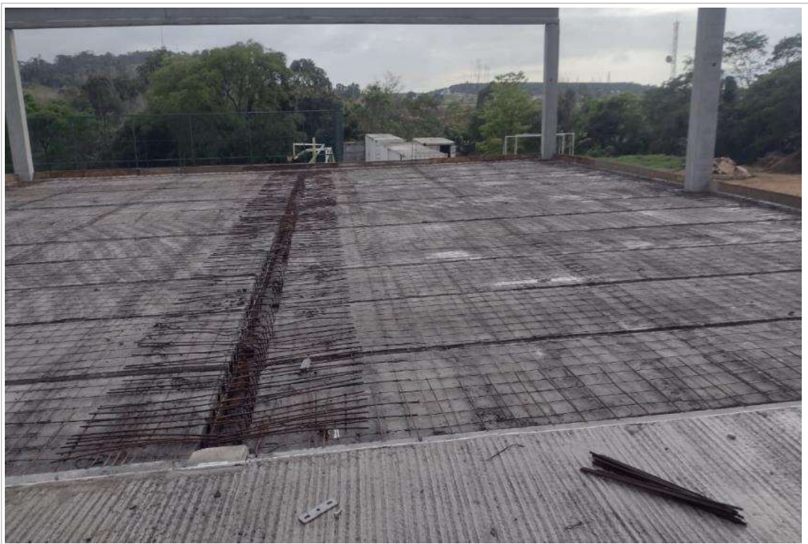
Foto 4: Montagem Laje Alveolar - Aditivo;
