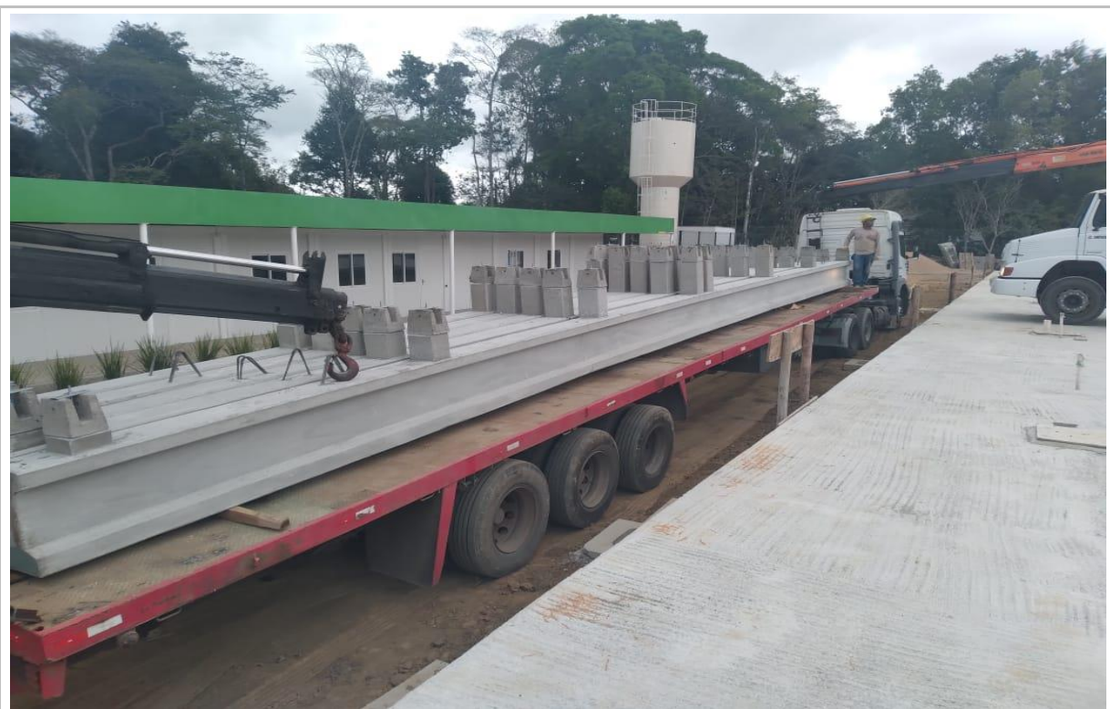
Foto 2: Item 4.2.1 : Estrutura Pré Moldada: Transporte e Descarga das Vigas Protendidas;
