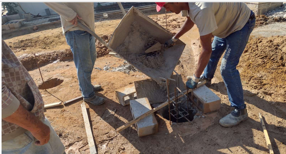
Foto 13: Armadura e Concretagem Estaca Broca;
