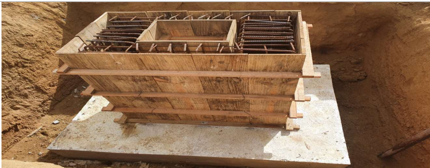
Foto 7: Item 4.1.6: Montagem de Fôrma; Item 4.1.9 a 4.1.15: Armadura de Bloco, Viga e Sapata
