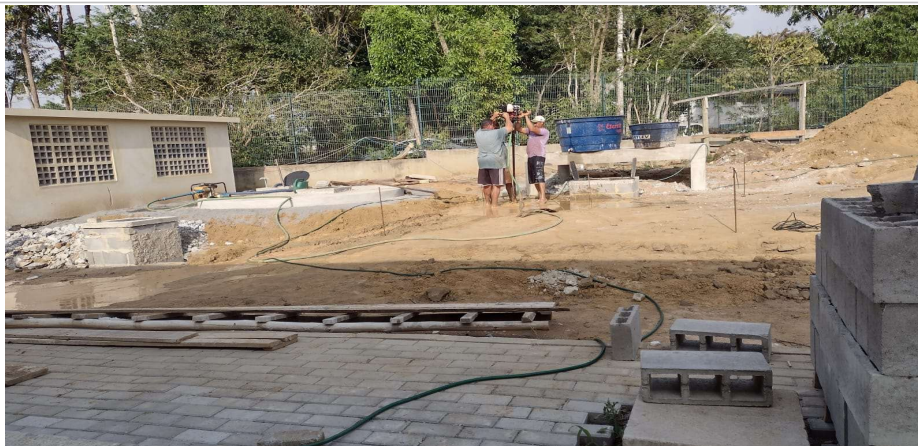
Foto 12: Perfuração Estaca Broca;
