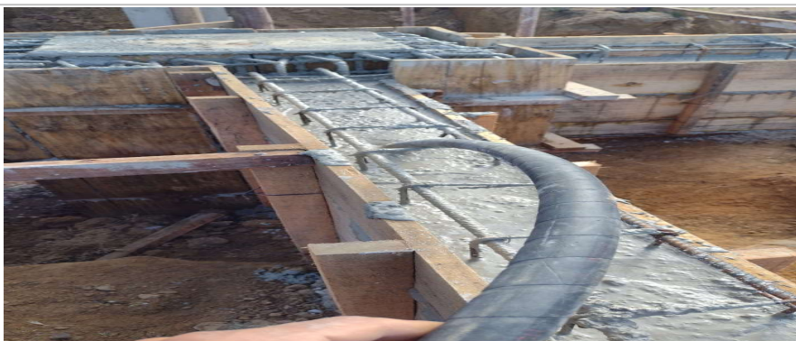
Foto 2: Item 4.1.1: Concretagem das vigas (térreo e depósito)
