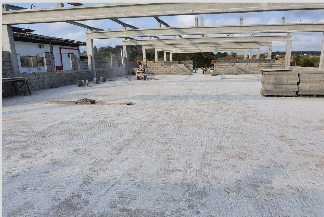
Foto 2: Item 4.2.1 : Estrutura Pré Moldada: Transporte - Montagem;
