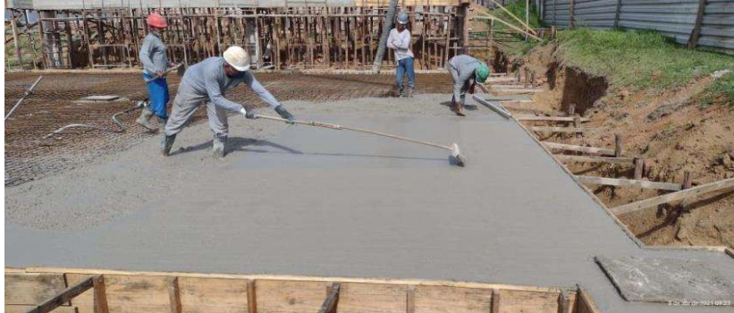
Foto 1: Item 4.1.3: Concretagem do Radier do Depósito;
