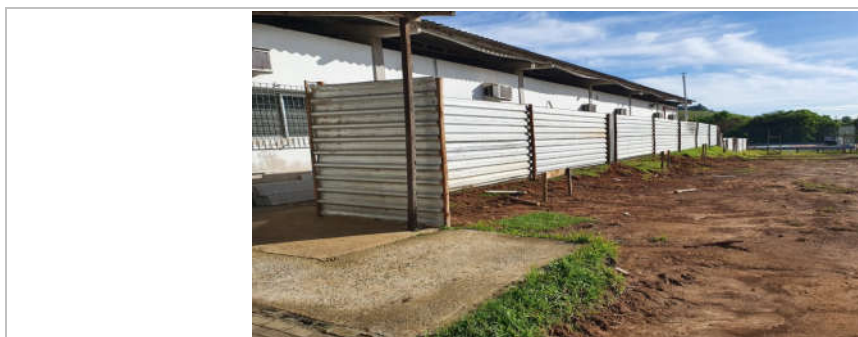
Foto 2: Item 2.1.2: Tapume; Item 3.1.1: Escavação mecânica em campo aberto
