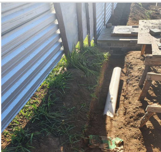
Foto 7: Item 14.4.3: Tubo Esgoto 200mm - Interligação das caixas;
