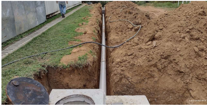
Foto 8: Item 14.12.2: Tubo rígido 200mm - Rede de Drenagem Pluvial (escavação, tubo e poço de visita);
