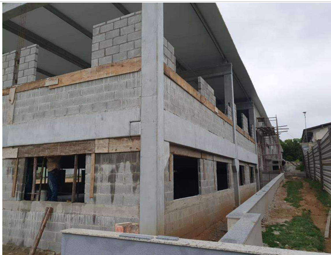
Foto 1: Item 5.1.1: Alvenaria; Item 5.3: Verga e Contraverga;
