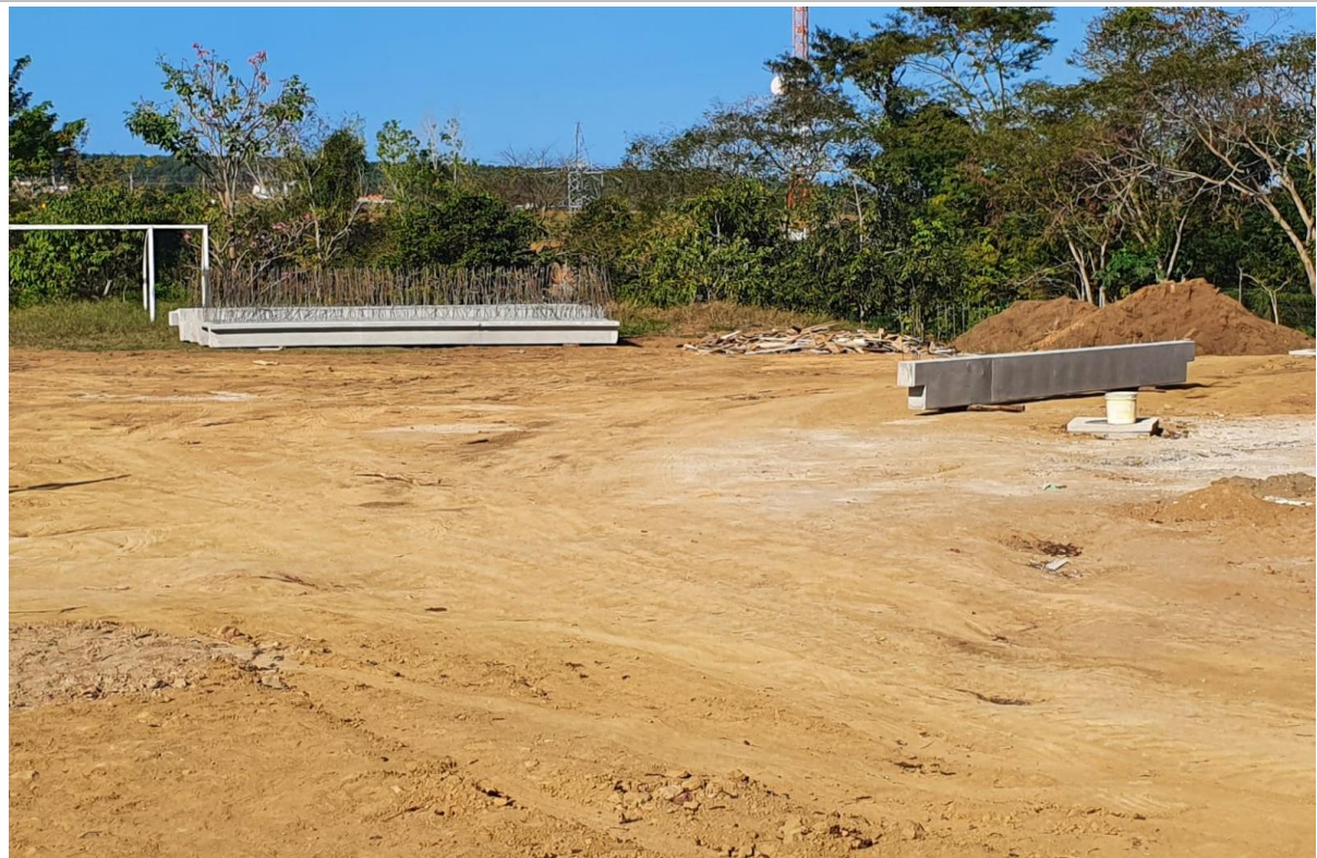
Foto 8: Item 4.2.1 : Estrutura Pré Moldada: Vigas da Laje armazenadas;
