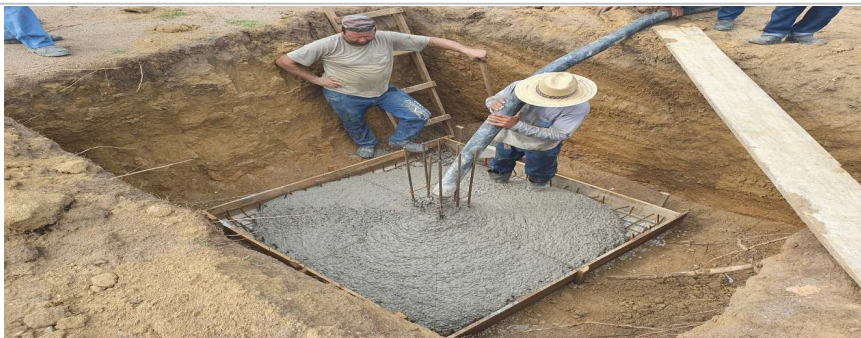
Foto 6: Item 4.1.1: Concretagem de Sapatas
