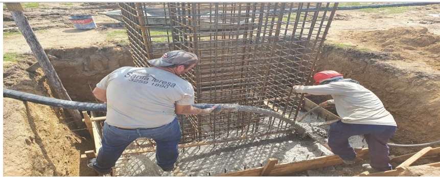
Foto 5: Item 4.1.1: Concretagem de Sapatas
