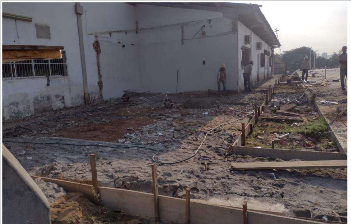
Foto 12: Demolição de Alvenaria;
