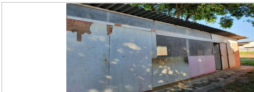
Foto 4: Item 2.2.2: Execução do Refeitório; Item 2.2.3: Execução do Depósito; Item 2.2.4: Execução do Almoxarifado
