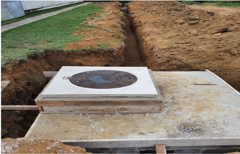
Foto 5: Item 14.5.9 e 14.5.10: Acréscimo e chaminé para os PV's água pluvial;
