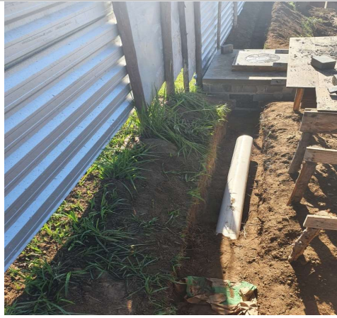
Foto 7: Item 14.4.3: Tubo Esgoto 200mm - Interligação das caixas;
