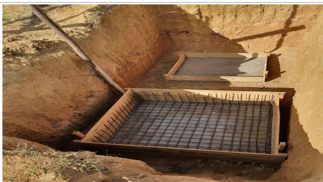
Foto 2: Item 4.1.2: Concreto Magro; Item 4.1.6: Montagem de Fôrma
