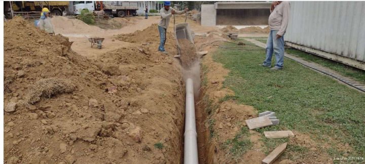
Foto 9: Itens 14.12.2: Tubo rígido 200mm - Rede de Drenagem Pluvial (escavação, tubo e reaterro com areia);
