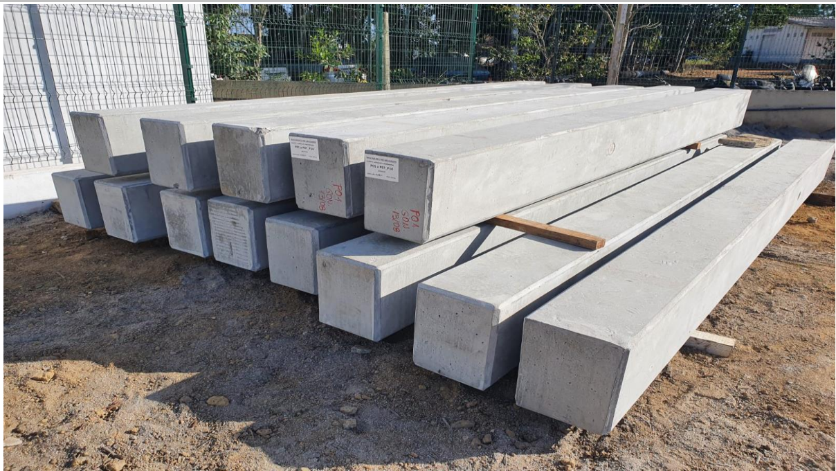
Foto 4: Item 4.2.1 : Estrutura Pré Moldada: Pilares;
