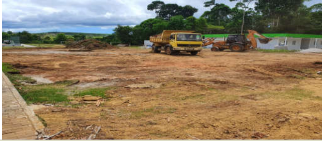
Foto 10: Item 2.4.1: Limpeza mecanizada do terreno; Item 3.1.2: Reaterro mecanizado
