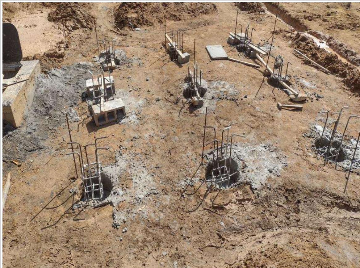
Foto 10: Concretagem Estacas Broca das Fundações do Reservatório Metálico;
