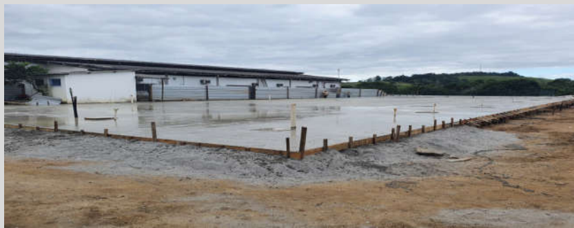
Foto 2: Item 4.1.3: Concretagem do Radier do Térreo;
