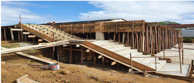
Foto 6: Item 4.1.8: Escoramento de fôrmas de Laje Térreo e Itens 4.1.16 a 4.1.19: Aramadura da escada;
