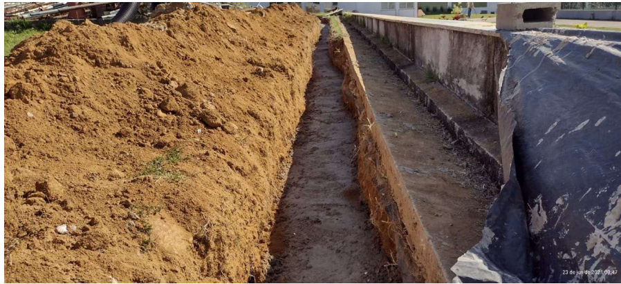
Foto 18: Item 15.3.5: Eletroduto PEAD 6" e item 15.4.3: Reaterro manual de vala e Item 15.4.4: Envolvimento em concreto;
