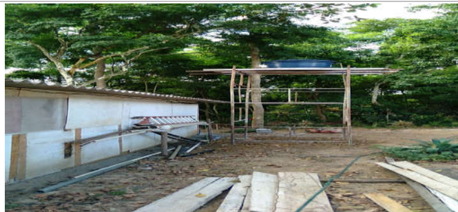
Foto 8: Item 2.2.8: Entrada provisória de água; Item 2.2.9: Caixa d'água
