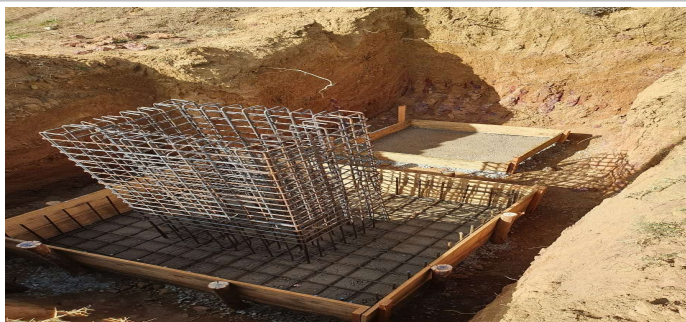
Foto 3: Item 4.1.2: Concreto Magro; Item 4.1.6: Montagem de Fôrma; Item 4.1.9 a 4.1.15: Armadura de Bloco, Viga e Sapata
