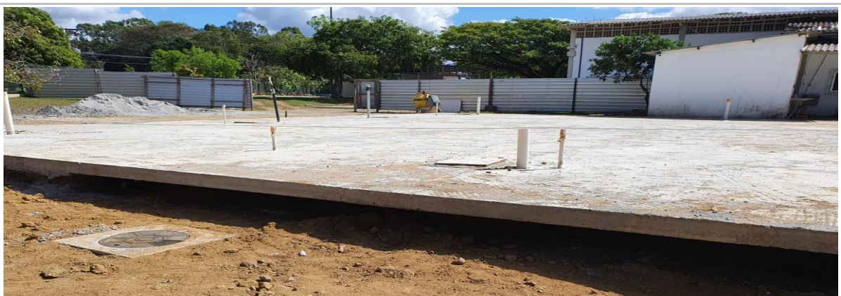
Foto 9: Item 14.5.11: Tampas FoFo PV's água pluvial;
