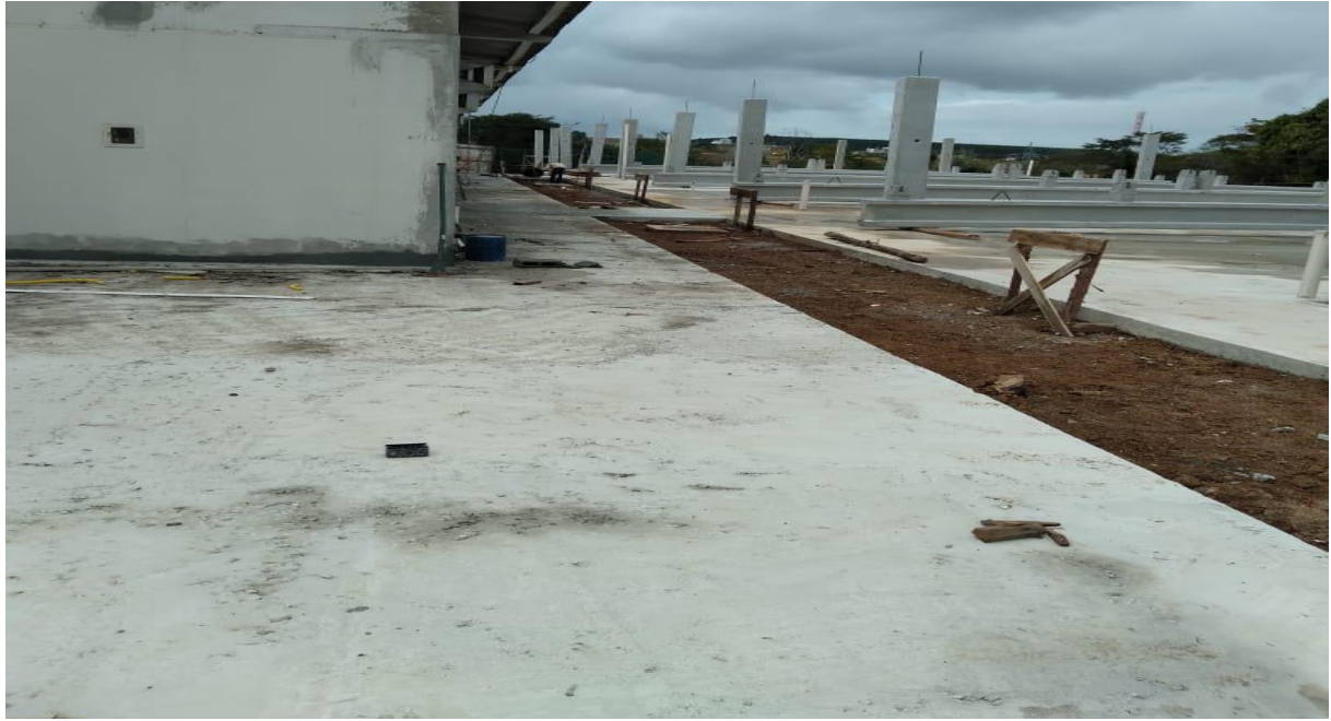
Foto 3: Item 4.2.1 : Estrutura Pré Moldada: Vigas Protendidas e Pilares posicionados para a montagem;
