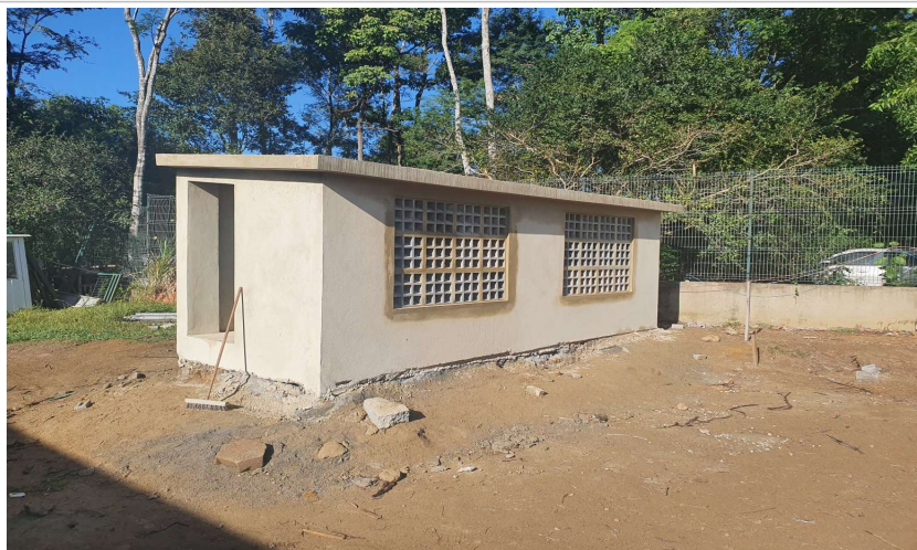
Foto 1: Item 5.1.1 : Alvenaria Casa de Bombas e Cisternas, Item 12.2.2: Chapisco e Item 12.2.3: Emboço;
