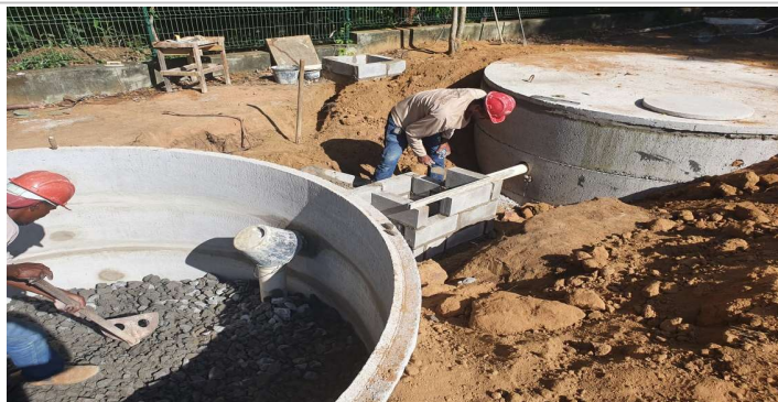
Foto 14: Item 14.6.2: Filtro em anel de concreto pré moldado - Inclusive brita 3 e Item 14.14.1: Escavação Mecanizada;
