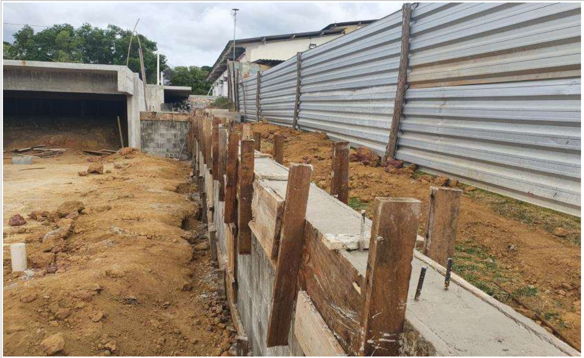
Foto 11: Muro de "arrimo";
