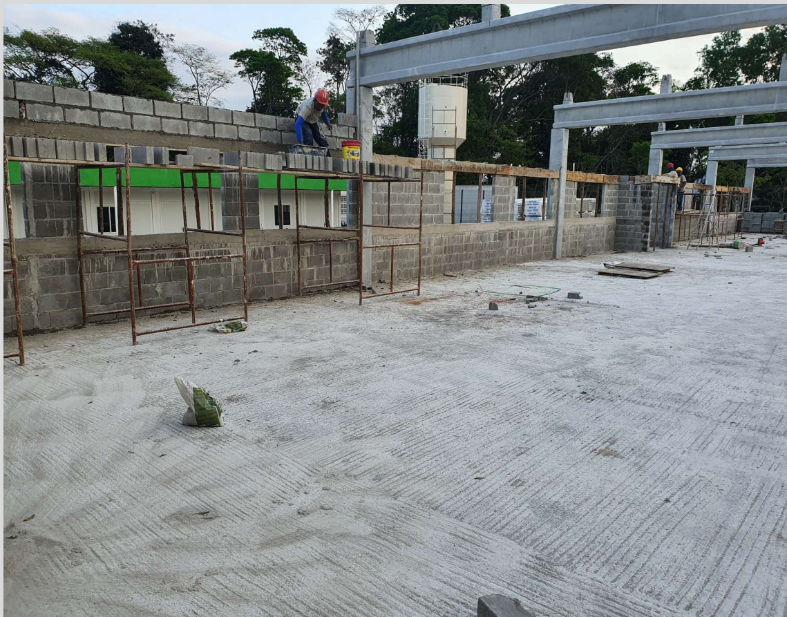
Foto 1: Item 2.1.3 : Montagem de Andaime;
