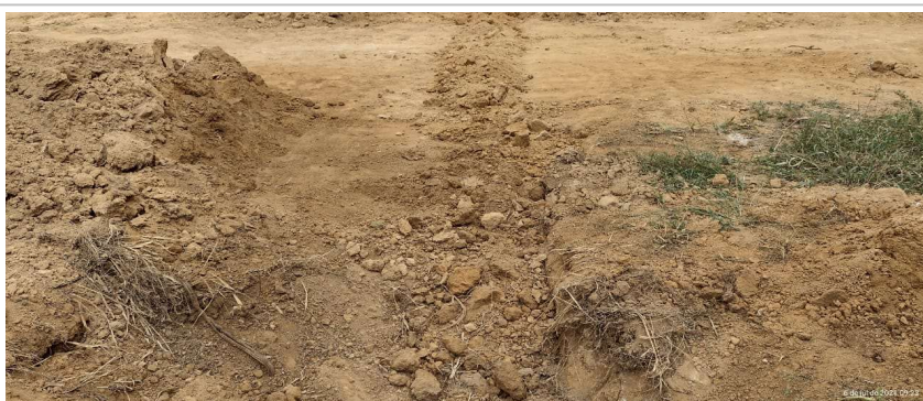
Foto 16: Item 14.14.2: Reaterro manual de valas;
