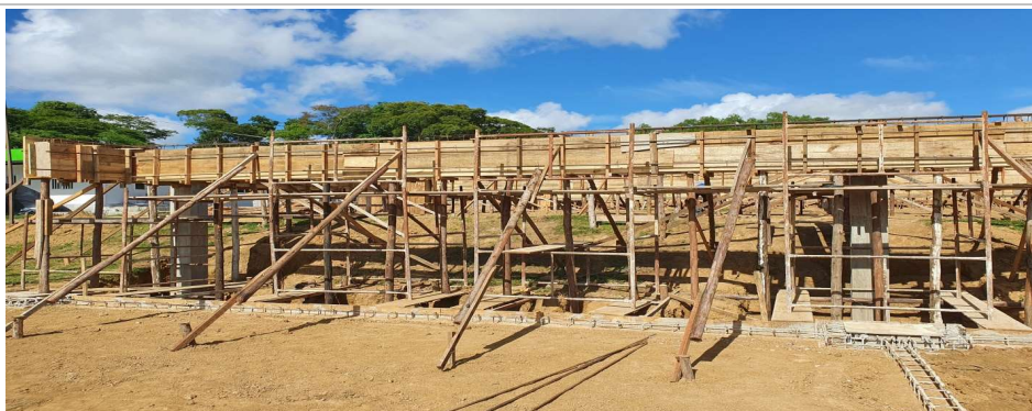
Foto 4: Item 4.1.6: Fôrma de Vigas;
