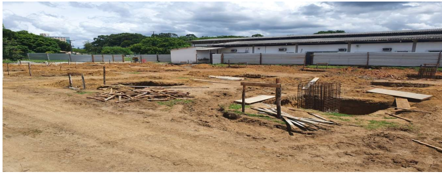
Foto 4: Item 3.2.1: Escavação Sapatas; Item 3.2.3: Carga de Material Escavado; Item 3.2.3: Retirada de Material Escavado
