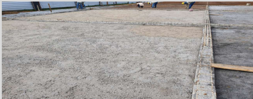
Foto 3: Item 4.1.2: Concreto Magro Térreo;
