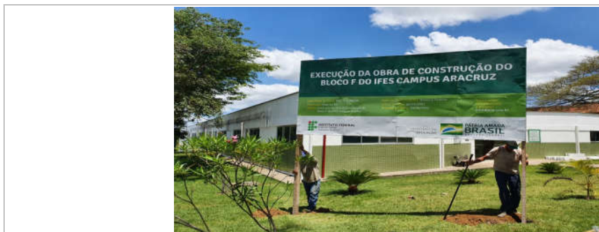
Foto 1: Item 2.1.1: Placa de Obra
