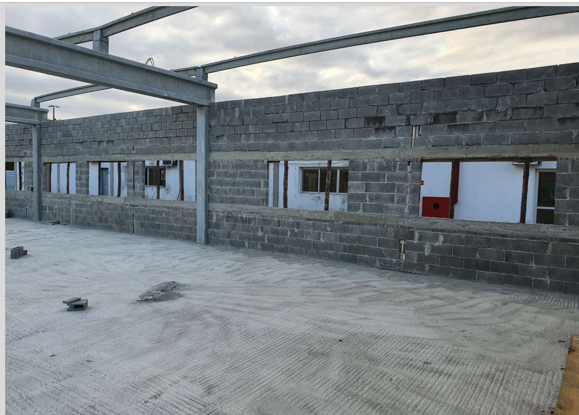
Foto 6: Itens 5.1.1, 5.3.1, 5.3.2, 5.3.3 e 5.3.4: Alvenaria de Blocos e Vergas;
