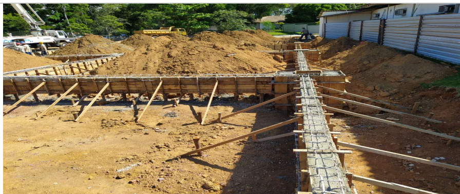
Foto 3: Item 4.1.1: Concretagem de vigas; Item 4.1.6: Fôrmas de Vigas; Item 4.1.9 a 4.1.15: Armadura de Vigas;
