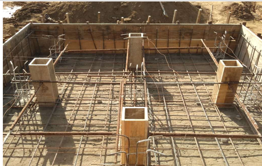
Foto 15: Concreto magro, Armadura e fôrma bloco de apoio do reservatório;
