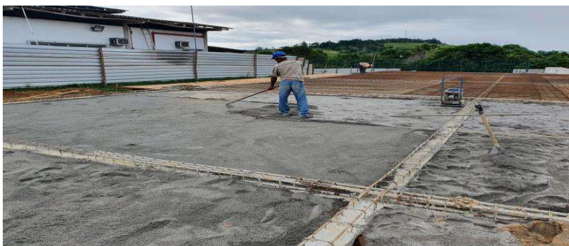
Foto 8: Item 4.1.7: Fôrma de Laje Térreo, Itens 4.1.16 a 4.1.19: Aramadura de Laje e Item 4.1.20: Fornecimento de lona;
