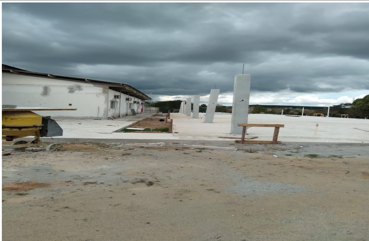
Foto 6: Item 4.2.1 : Estrutura Pré Moldada:Pilares posicionados para montagem;
