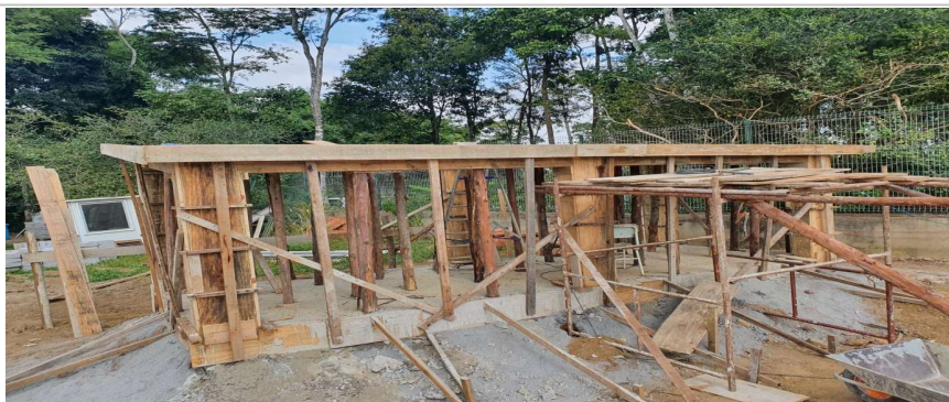
Foto 2: Itens 4.2.4 a 4.2.16, : Estrutura Casa de Bombas e Cisternas;
