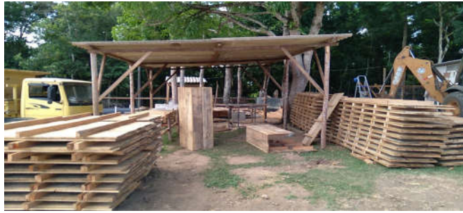
Foto 6: Item 2.2.6: Execução da Central de fôrmas
