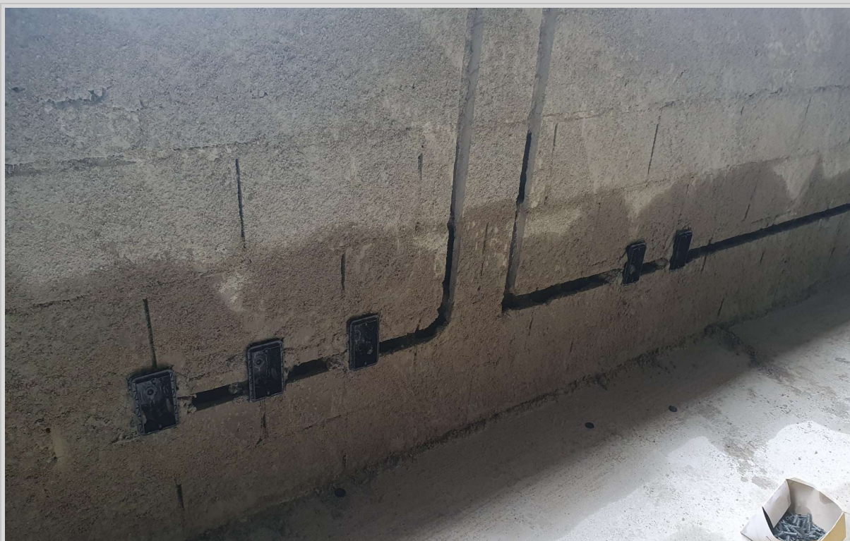
Foto 8: Item 12.2.3: Emboço Interno;
