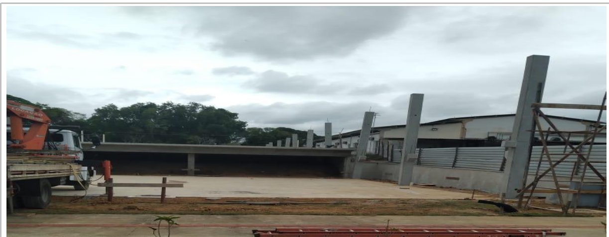
Foto 4: Item 4.2.1 : Estrutura Pré Moldada: Pilares;
