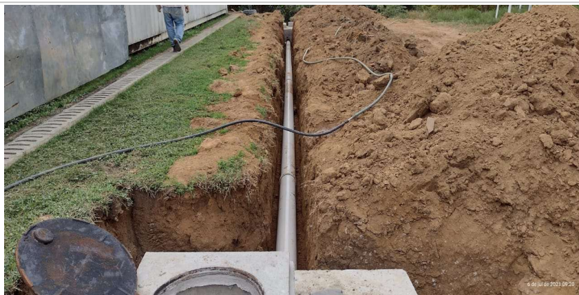
Foto 11: Itens 14.12.2: Tubo rígido 200mm - Rede de Drenagem Pluvial (escavação, tubo e poço de visita);
