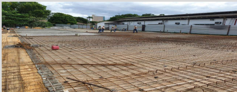
Foto 4: Itens 4.1.16 a 4.1.19: Armadura de Laje;
