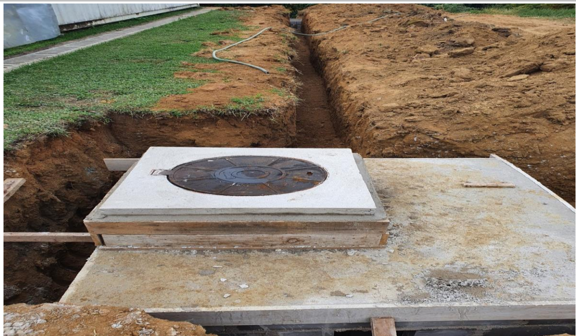
Foto 9: Item 14.5.11: Tampas FoFo PV's água pluvial;
