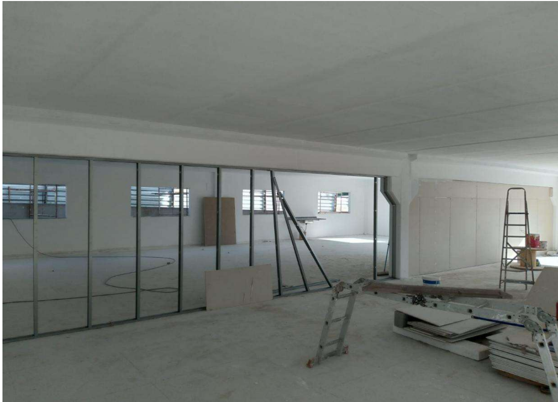
Foto 5: Revestimento no teto do Depósito;
