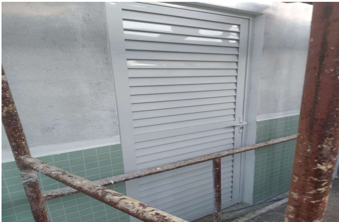
Foto 8: Instalação Porta de Acesso ao Porão;
