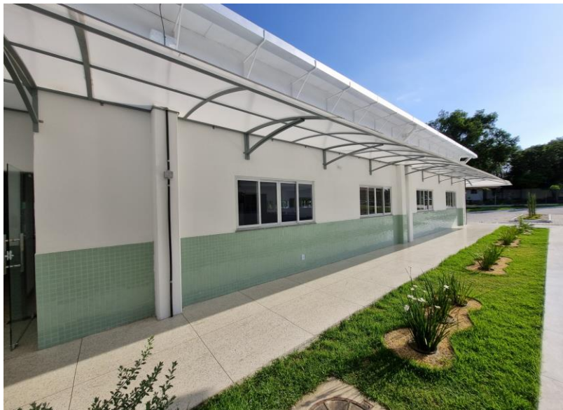
Foto 9: Bloco finalizado - lateral
