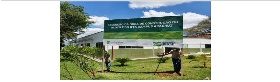
Foto 1: Item 2.1.1: Placa de Obra
