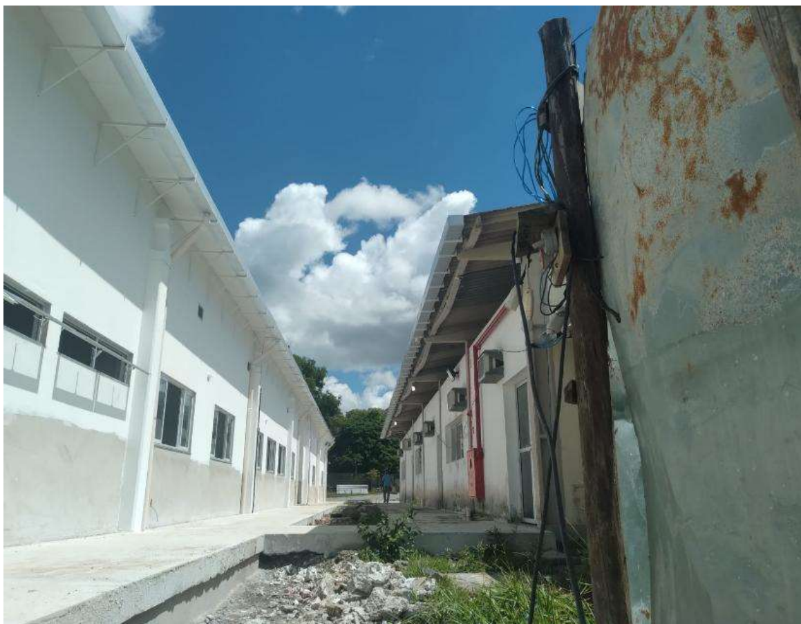
Foto 1: Calha Bloco E;
