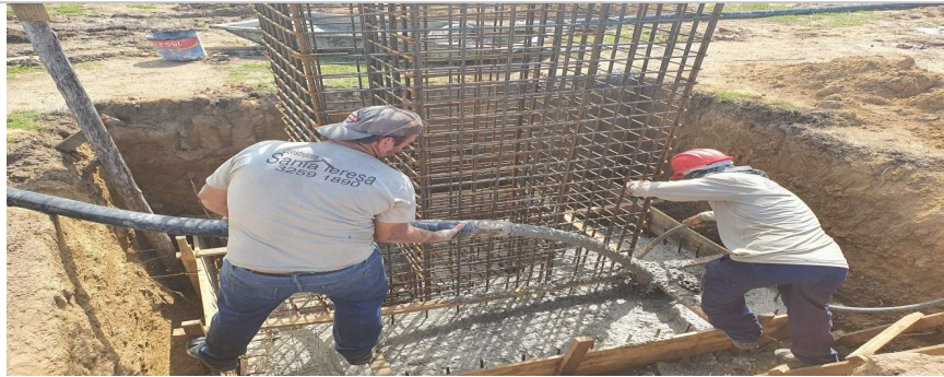
Foto 5: Item 4.1.1: Concretagem de Sapatas
