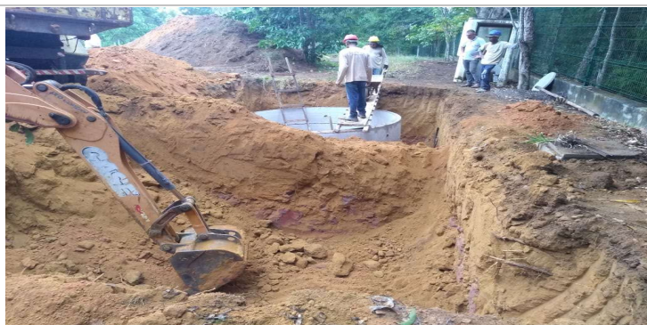
Foto 15: Item 14.14.1: Escavação mecanizada;
