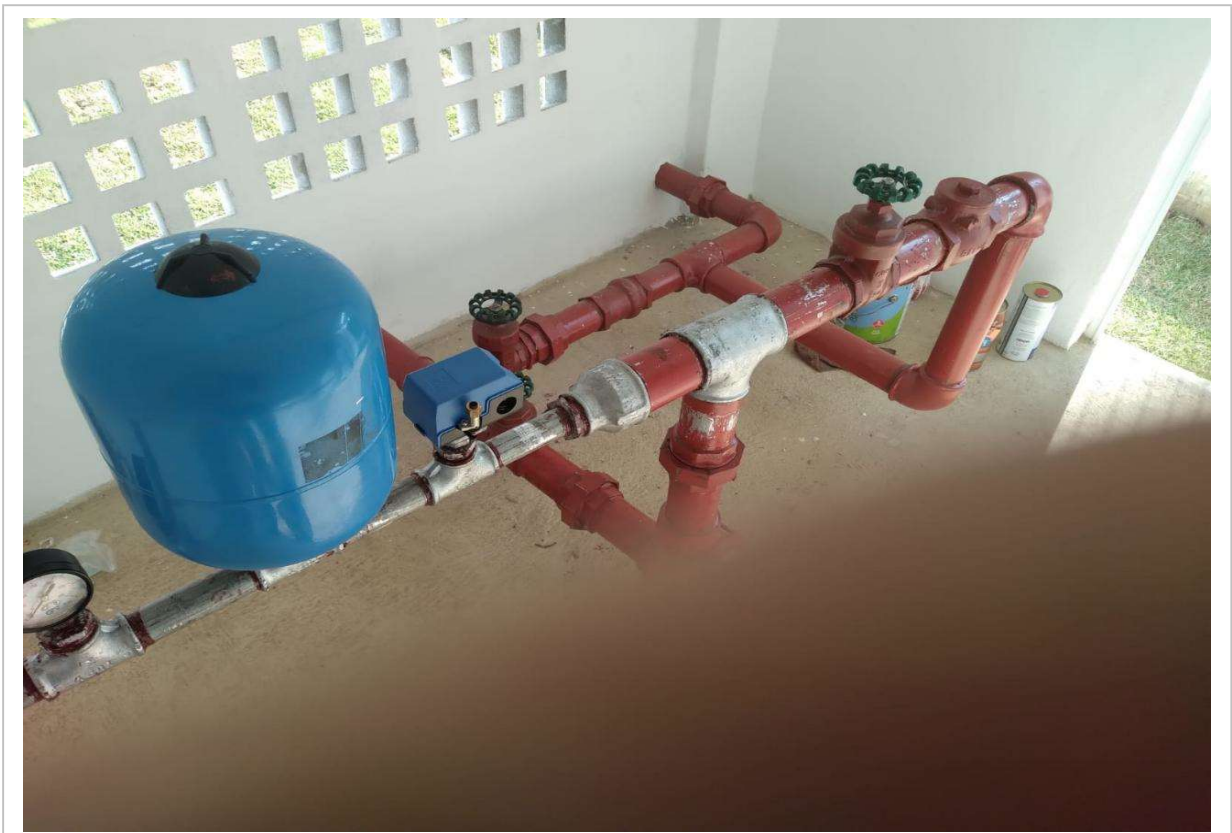
Foto 4: Instalação Kit Hidropneumático;
