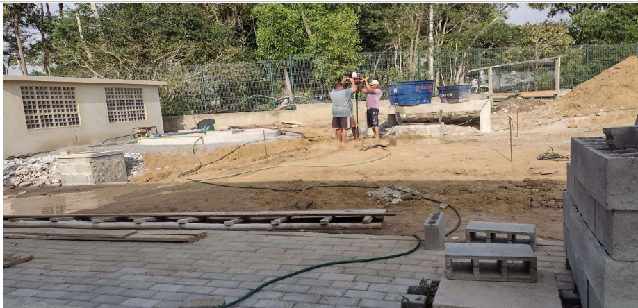
Foto 12: Perfuração Estaca Broca;
