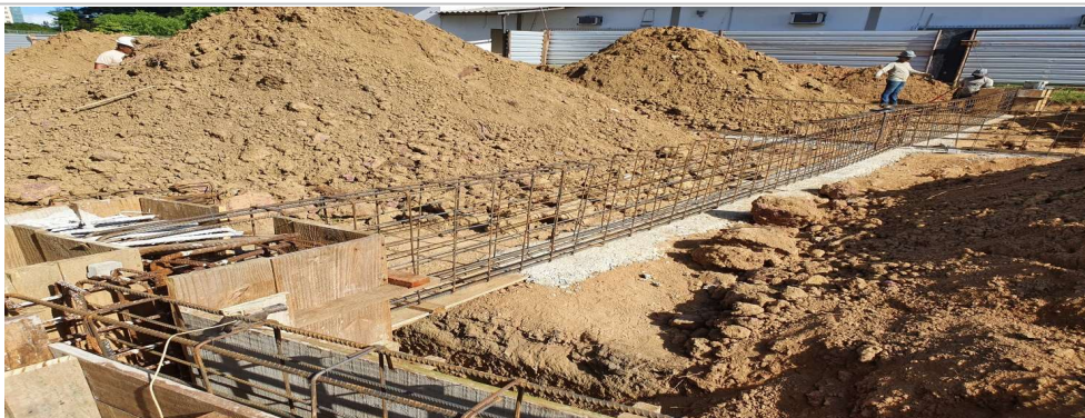
Foto 5: Item 4.1.9 a 4.1.15: Armadura de Vigas;
