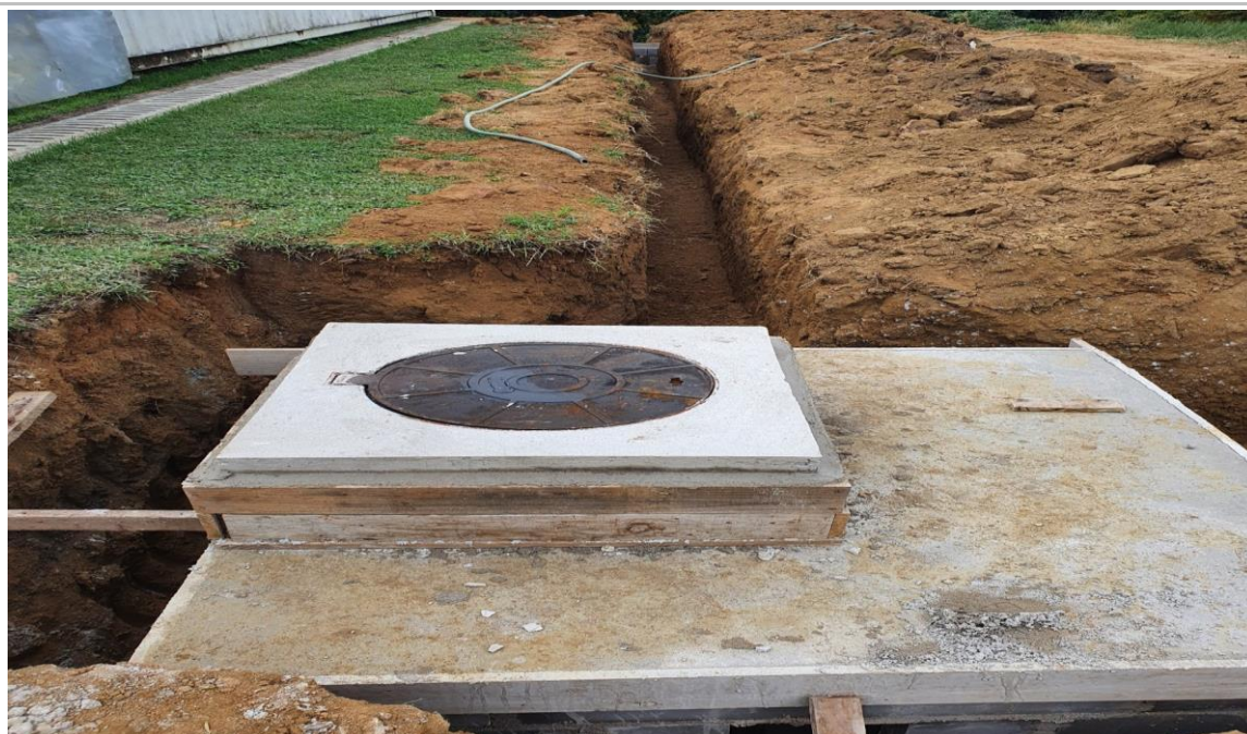
Foto 9: Item 14.5.11: Tampas FoFo PV's água pluvial;
