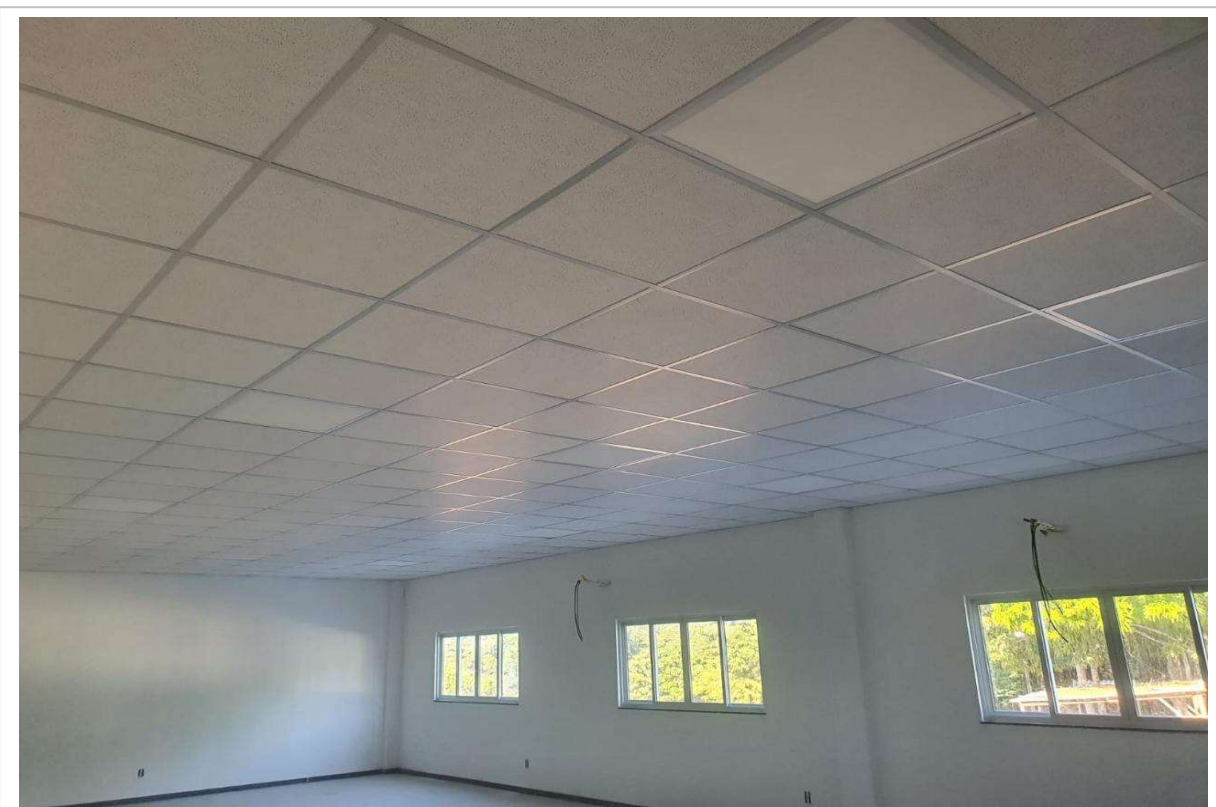
Foto 4: Instalação Forro e luminárias;
