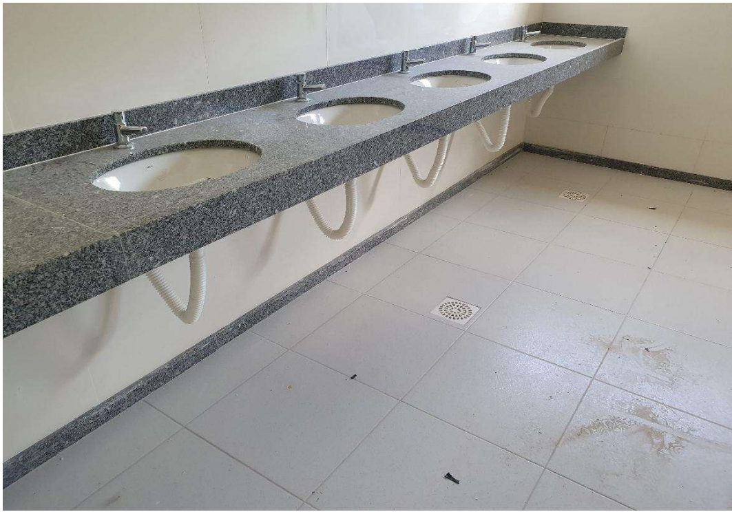
Foto 20: Item 20: Aparelhos Hidro Sanitários; Item 22.1: Bancada em granito;
