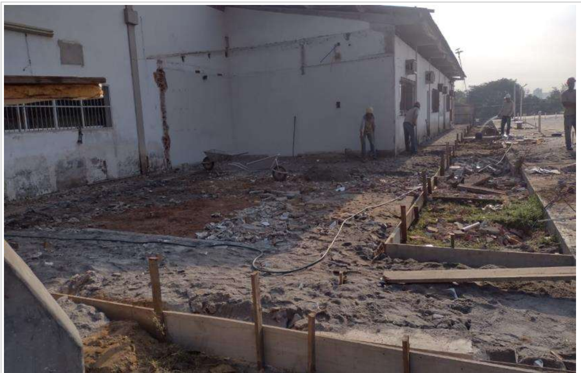
Foto 12: Demolição de Alvenaria;
