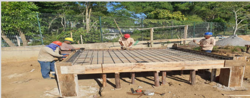
Foto 6: Item 4.1.6: fôrmas do reservatório e Itens 4.1.11 a 4.1.13 e 4.1.16 a 4.1.19; Armadura Reservatórios;
