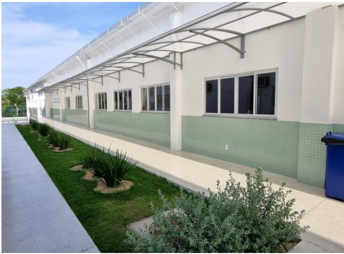
Foto 8: Bloco finalizado - lateral
