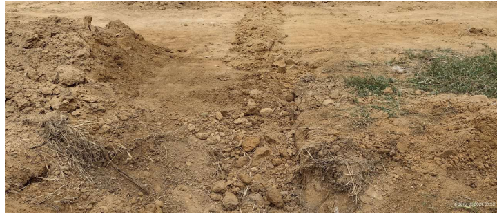
Foto 10: Item 14.14.2: Reaterro manual de valas;
