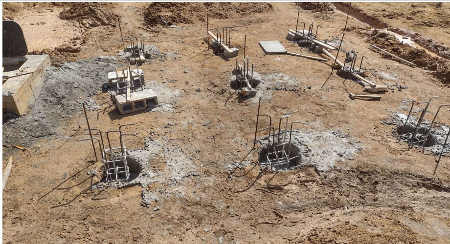
Foto 14: Armadura e Concretagem Estaca Broca;
