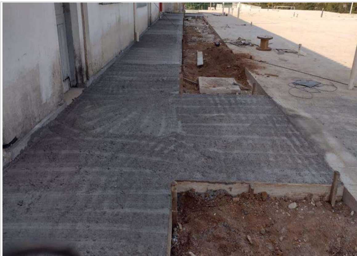
Foto 13: Concretagem Piso Externo;
