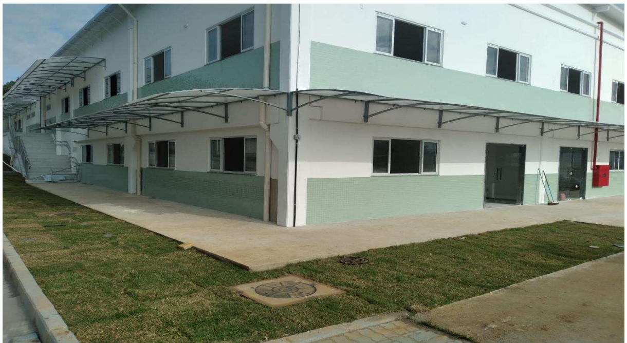
Foto 10: Instalação portas depósito térreo e caixa para hidrante;
