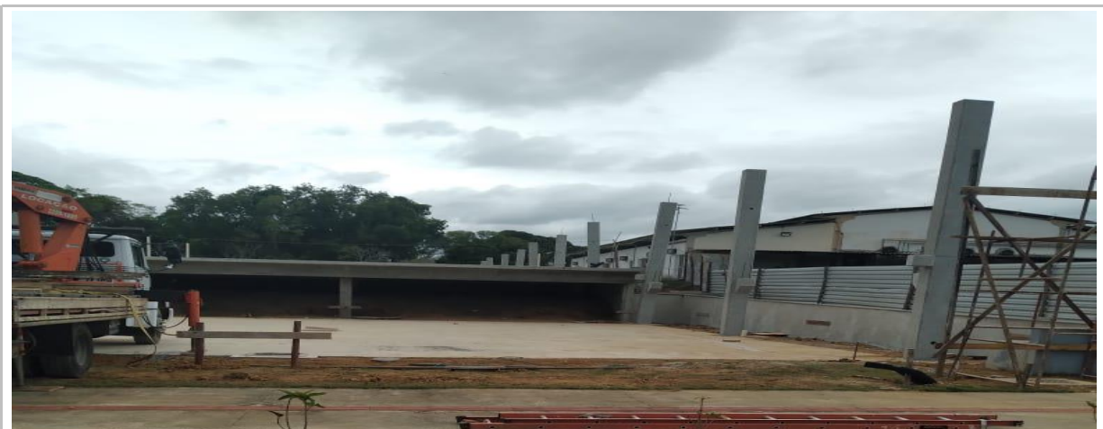
Foto 4: Item 4.2.1 : Estrutura Pré Moldada: Pilares;
