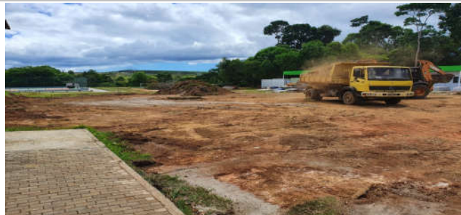
Foto 13: Item 3.1.3: Carga e descarga mecânica; Item 3.1.4: Transporte de entulho
