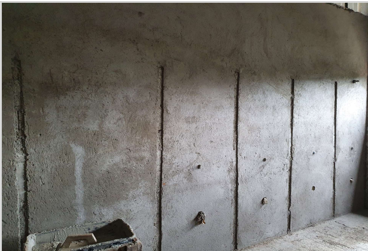
Foto 7: Item 12.1.1: Emboço para recebimento de cerâmica nos WC's;
