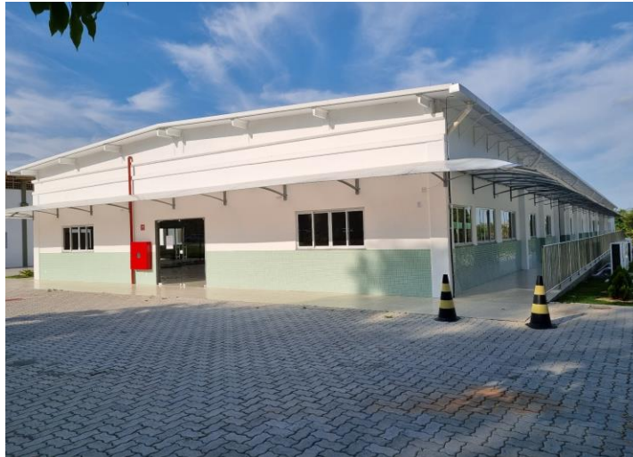
Foto 2: Bloco finalizado - frente
