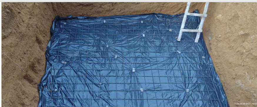
Foto 3: Itens 4.2.4 a 4.2.15, : Estrutura Casa de Bombas e Cisternas;
