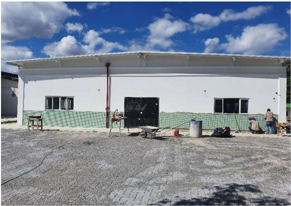
Foto 5: Revestimento externo;
