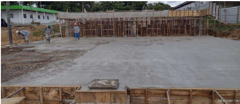
Foto 2: Item 4.1.3: Concretagem do Radier do Depósito;
