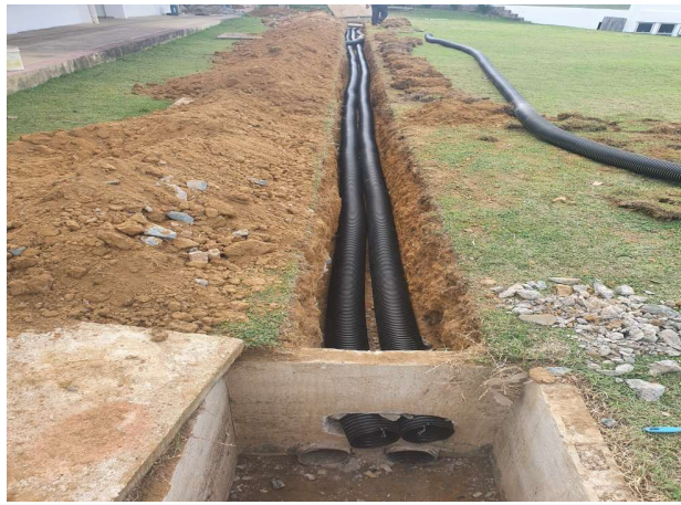
Foto 17: Item 15.3.5: Eletroduto PEAD 6" e item 15.4.2: Escavação manual de vala;
