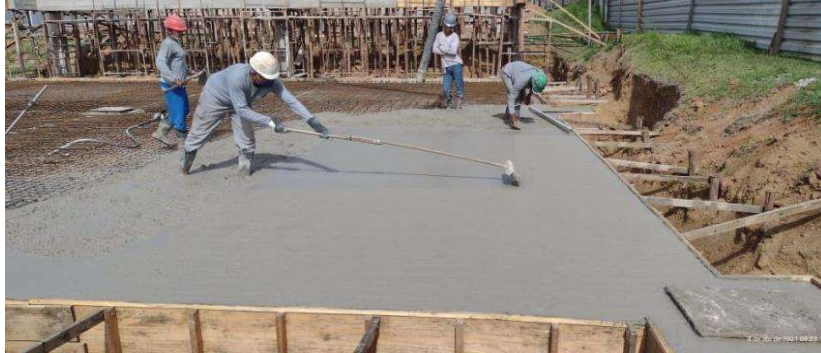
Foto 1: Item 4.1.3: Concretagem do Radier do Depósito;
