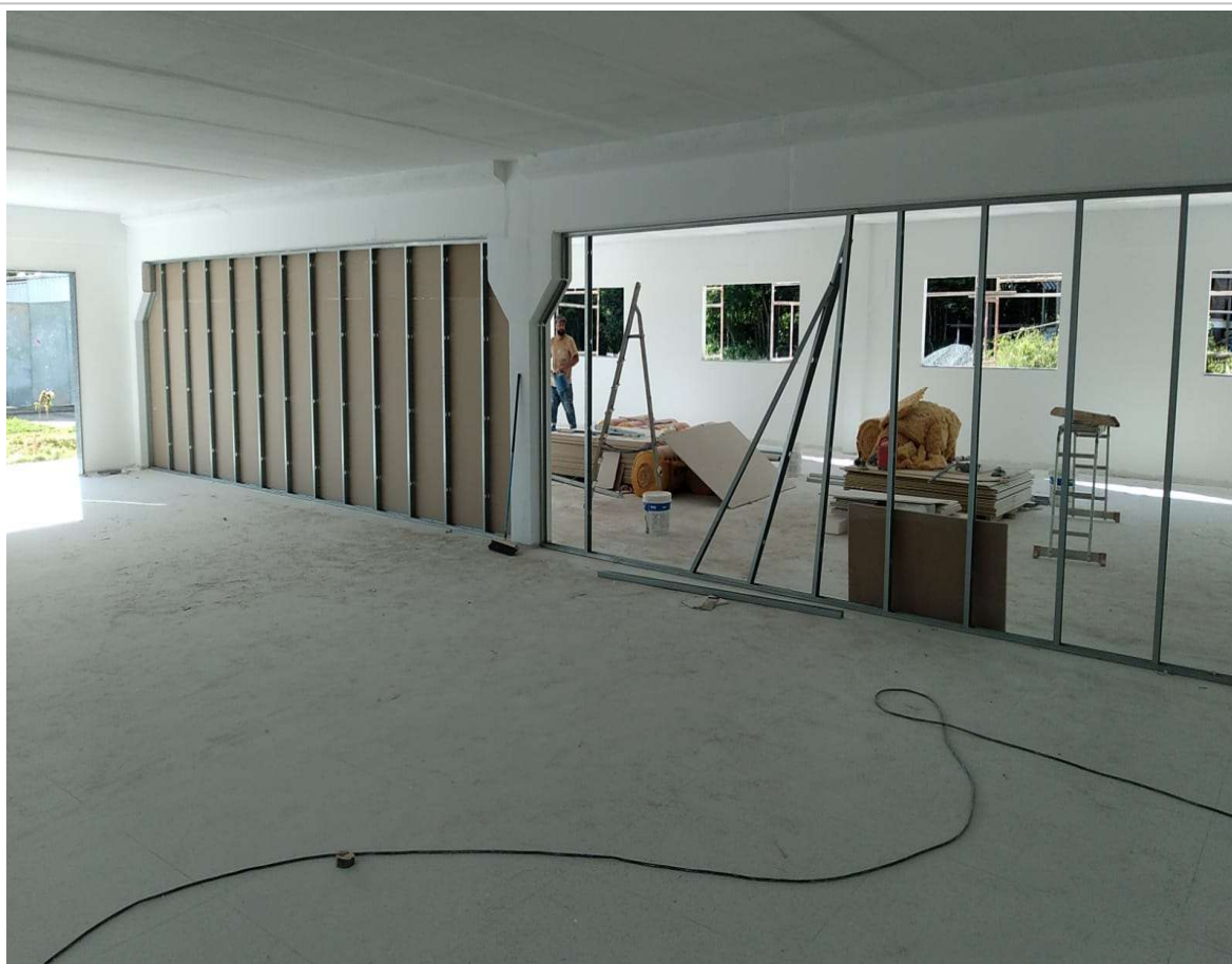
Foto 1: Item 5.2.1: Paredes em Dry Wall: Depósito;
