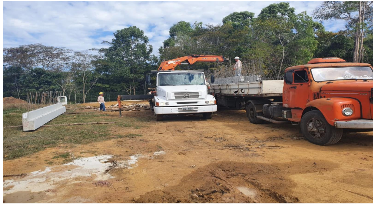
Foto 1: Item 4.2.1 : Estrutura Pré Moldada: Transporte e Descarga das Vigas da Laje;
