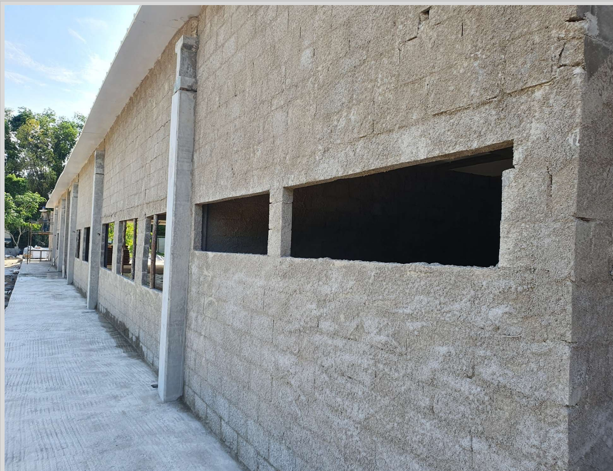
Foto 1: Item 5.1.1: Alvenaria; Item 5.3: Verga e Contraverga; Item 12.2.2: Chapisco
