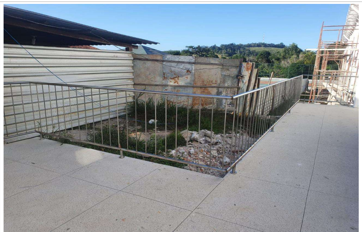
Foto 3: Instalação do Guarda Corpo
