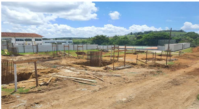
Foto 1: Item 2.1.2: Tapume; Item 4.1.9 a 4.1.15: Armadura de Bloco, Viga e Sapata
