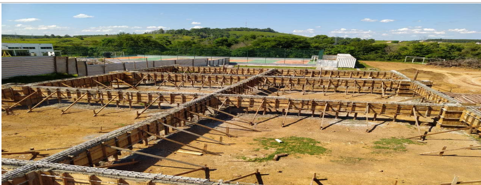
Foto 6: Item 4.1.1: Concretagem de vigas; Item 4.1.6: Fôrmas de Vigas; Item 4.1.9 a 4.1.15: Armadura de Vigas;
