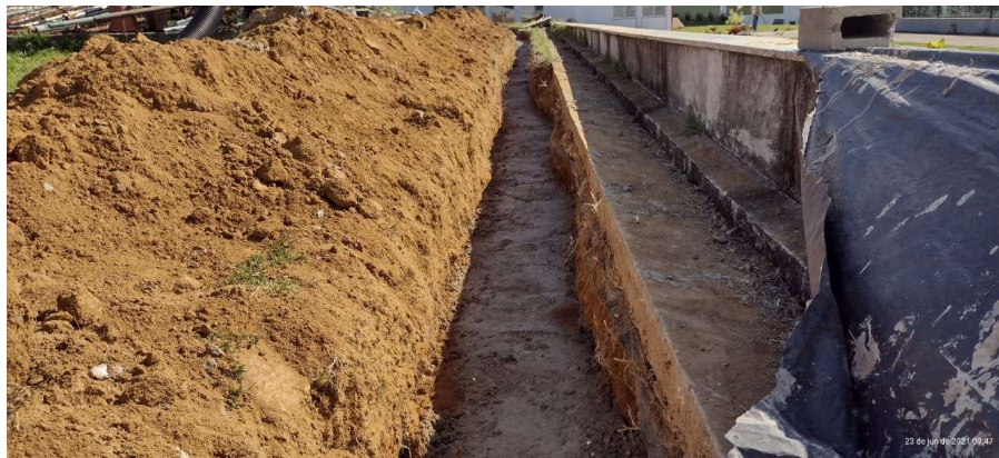
Foto 18: Item 15.3.5: Eletroduto PEAD 6" e item 15.4.3: Reaterro manual de vala e Item 15.4.4: Envolvimento em concreto;
