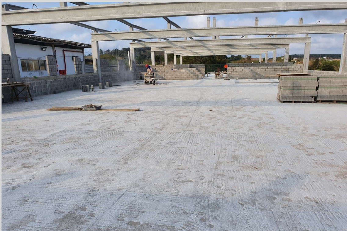
Foto 2: Item 4.2.1 : Estrutura Pré Moldada: Transporte - Montagem;
