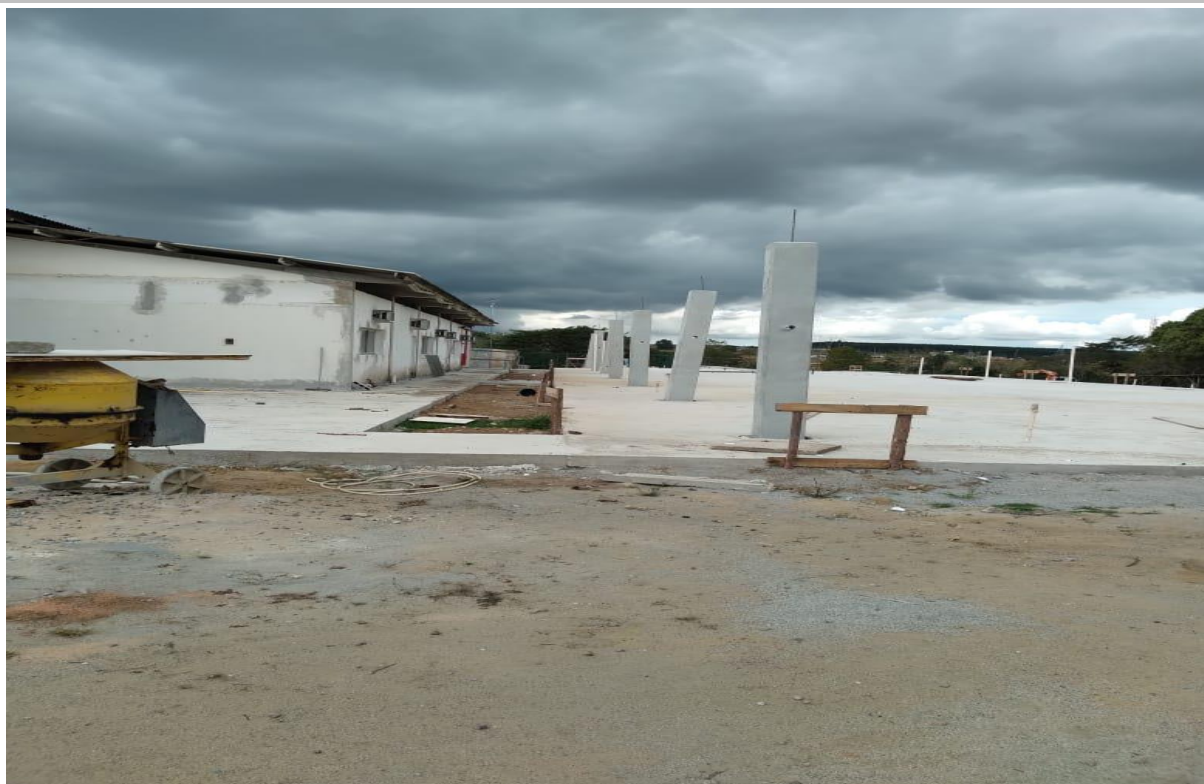
Foto 6: Item 4.2.1 : Estrutura Pré Moldada:Pilares posicionados para montagem;
