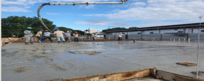
Foto 1: Item 4.1.3: Concretagem do Radier do Térreo;
