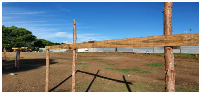
Foto 9: Item 2.3.1: Locação convencional de obra
