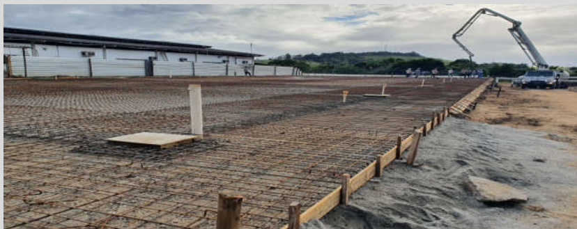
Foto 5: Itens 4.1.16 a 4.1.19: Armadura de Laje;
