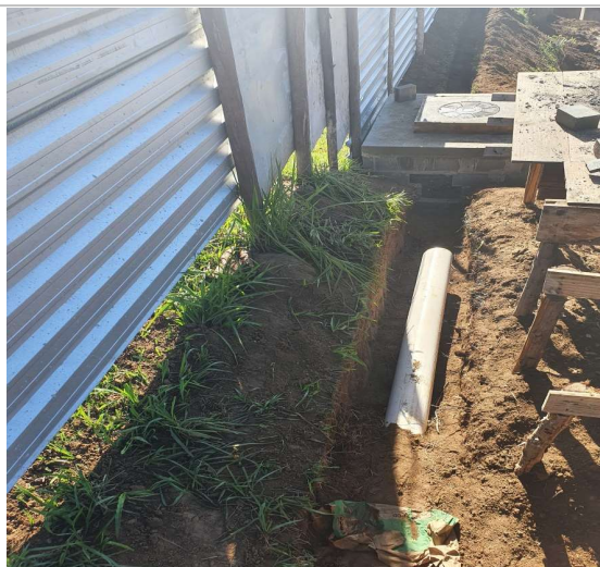
Foto 7: Item 14.4.3: Tubo Esgoto 200mm - Interligação das caixas;
