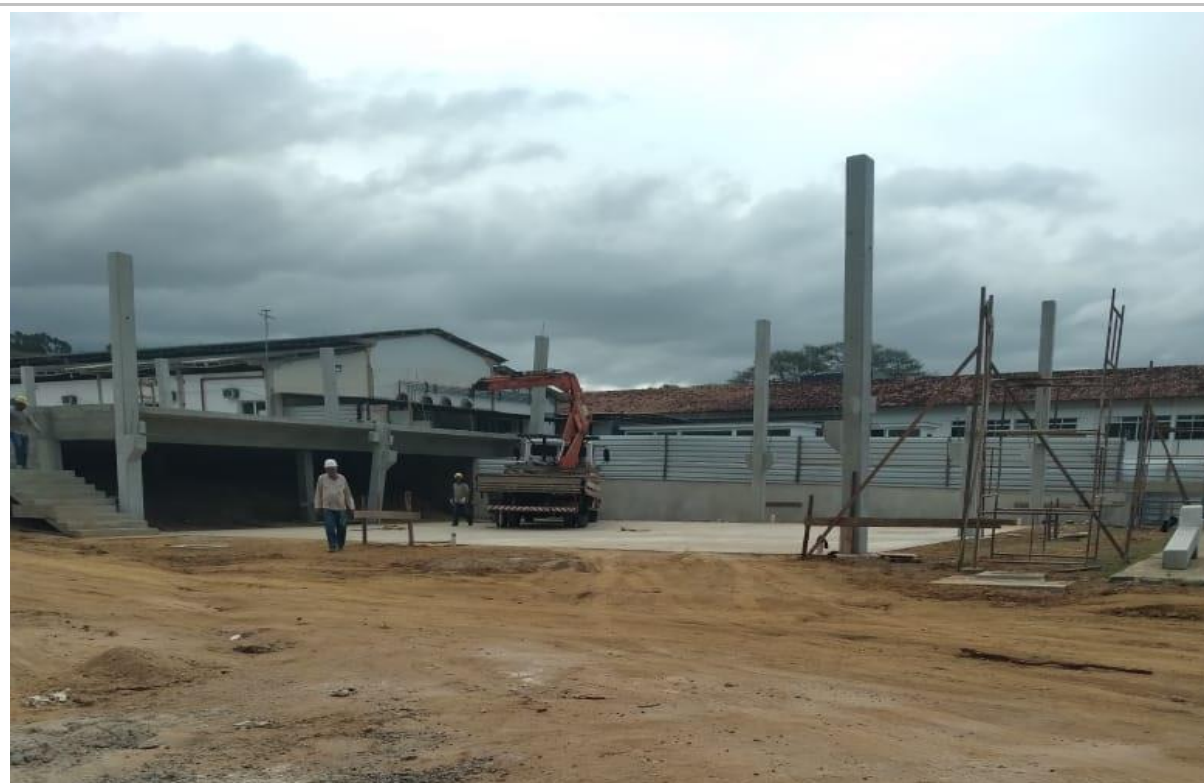
Foto 6: Item 4.2.1 : Estrutura Pré Moldada:Pilares posicionados para montagem;
