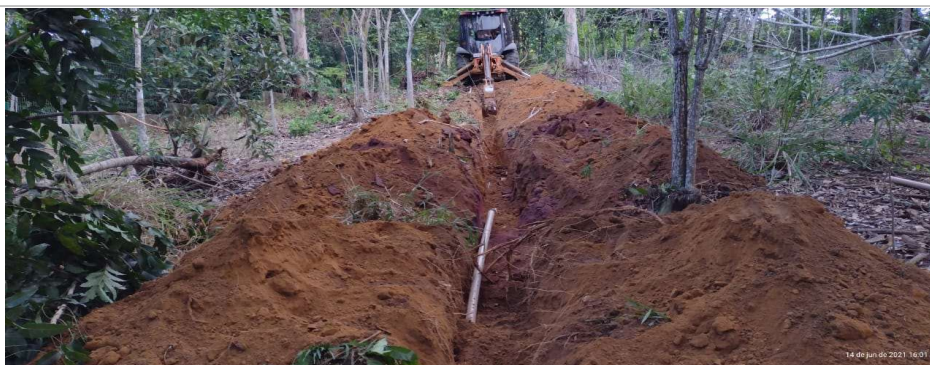
Foto 4: Item 14.1.5: Tubo soldavel 60mm para alimentação do castelo d'água;
