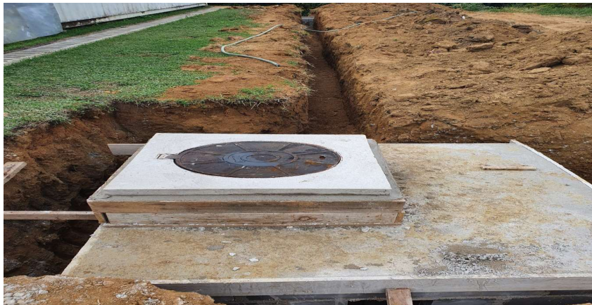
Foto 10: Itens 14.1.8 a 14.1.11: Poço de Visita Pluvial;
