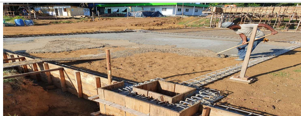
Foto 7: Item 4.1.2: Concreto magro para lastro sob laje depósito;
