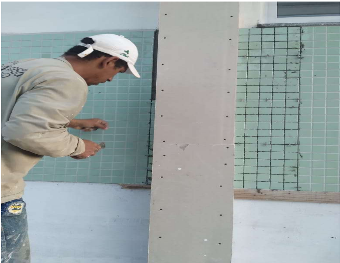
Foto 6: Instalação arremates de pastilhas e fechamento das descidas da tubulação de ar condicionado;
