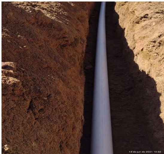
Foto 6: Item 14.4.3: Tubo Esgoto 100mm - Interligação das caixas e ligação com a fossa/filtro;
