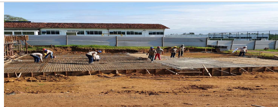
Foto 8: Item 4.1.2: Concreto magro para lastro sob laje depósito; Item 4.1.16 a 4.1.19: Armadura da laje do depósito;
