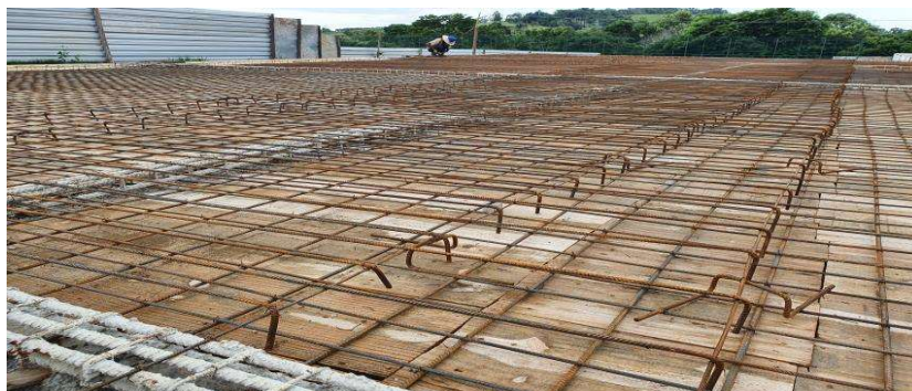
Foto 4: Item 4.1.7: Fôrma de Laje Térreo e Itens 4.1.16 a 4.1.19: Aramadura de Laje;
