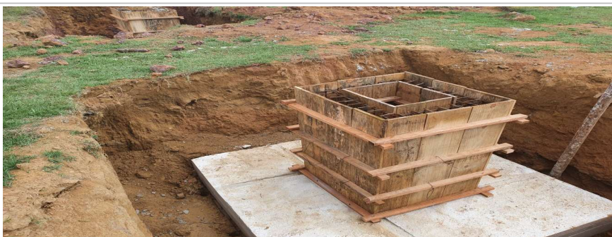
Foto 8: Item 4.1.6: Montagem de Fôrma; Item 4.1.9 a 4.1.15: Armadura de Bloco, Viga e Sapata
