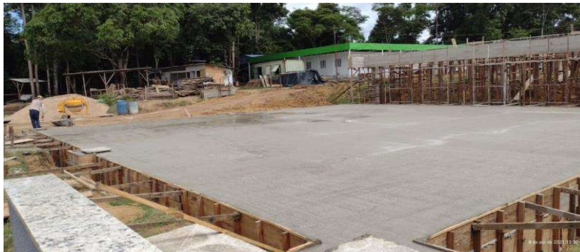
Foto 3: Item 4.1.3: Concretagem do Radier do Depósito;
