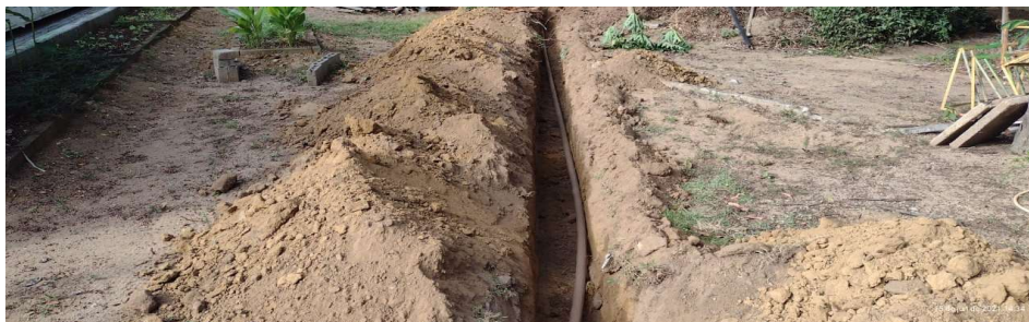
Foto 5: Item 14.1.5: Tubo soldavel 60mm para alimentação do castelo d'água;
