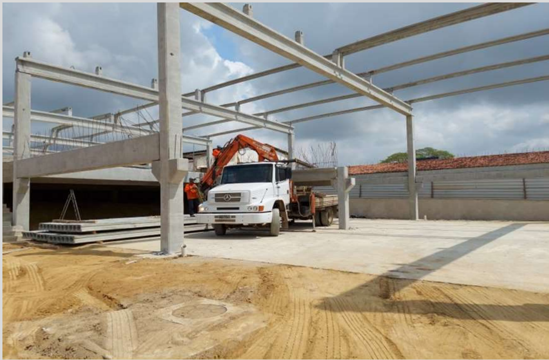
Foto 3: Item 4.2.1 : Estrutura Pré Moldada: Vigas Protendidas e Pilares posicionados - Montagem;
