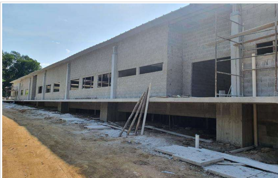
Foto 2: Item 2.1.3: Andaime; Item 5.1.1: Alvenaria; Item 5.3: Verga e Contraverga; Item 12.2.1: Chapisco Fachada;
