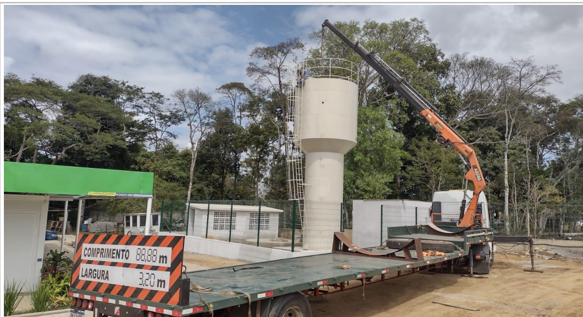
Foto 11: Item 14.13.1: Reservatório Metálico;
