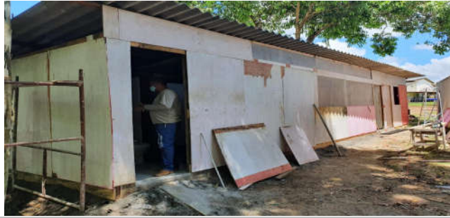
Foto 5: Item 2.2.5: Execução do Sanitário e Vestiário
