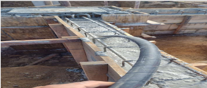
Foto 2: Item 4.1.1: Concretagem das vigas (térreo e depósito)
