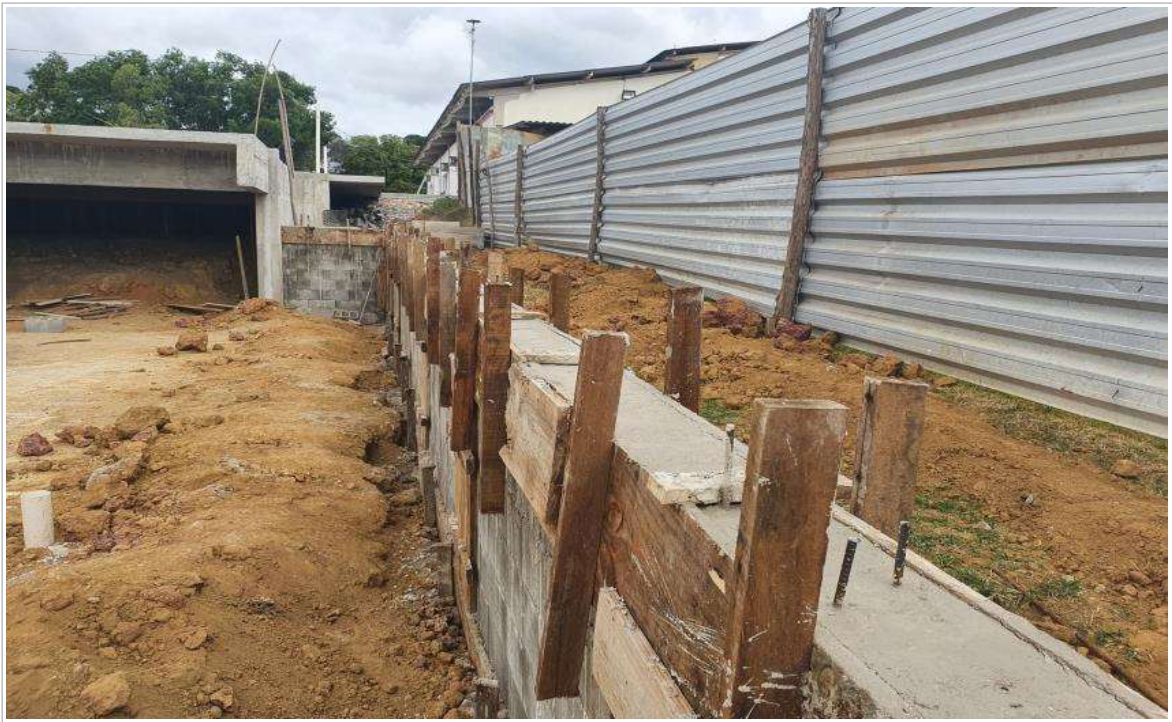
Foto 11: Muro de "arrimo";
