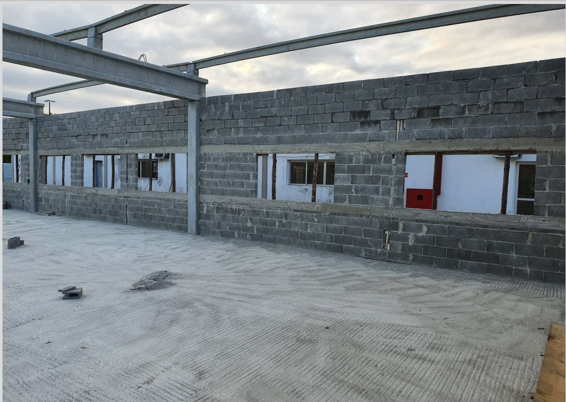
Foto 6: Itens 5.1.1, 5.3.1, 5.3.2, 5.3.3 e 5.3.4: Alvenaria de Blocos e Vergas;
