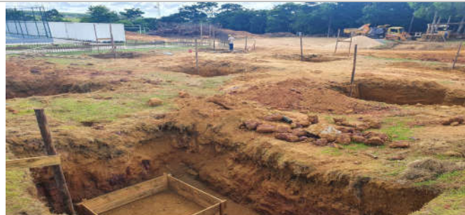
Foto 14: Item 3.2.1: Escavação mecânica
