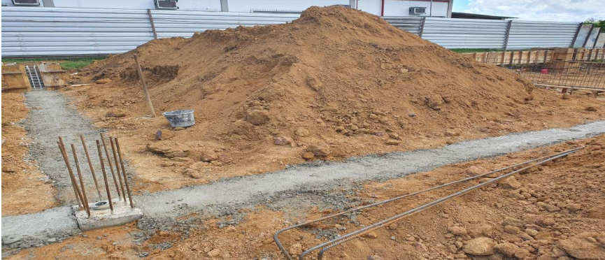
Foto 1: Item 3.2.1: Reaterro; Item 4.1.2: Concreto magro para lastro sob vigas;
