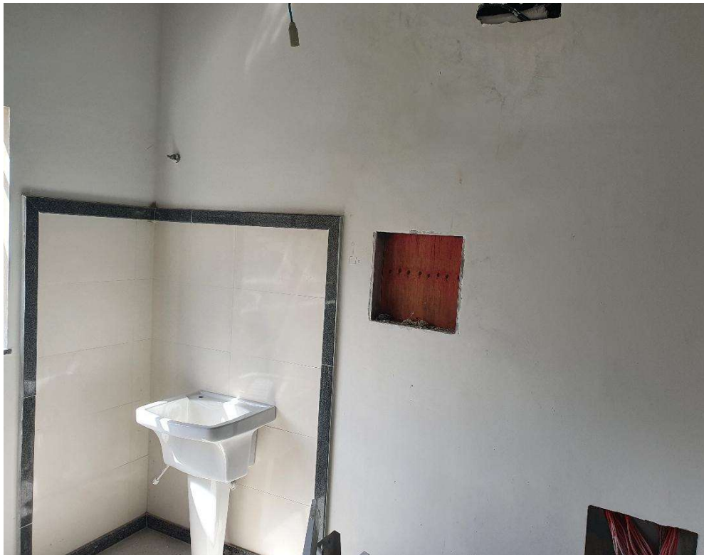
Foto 6: Item 12.3.1: Revestimento de Paredes Internas; Item 20.1.5: Tanque em louça;
