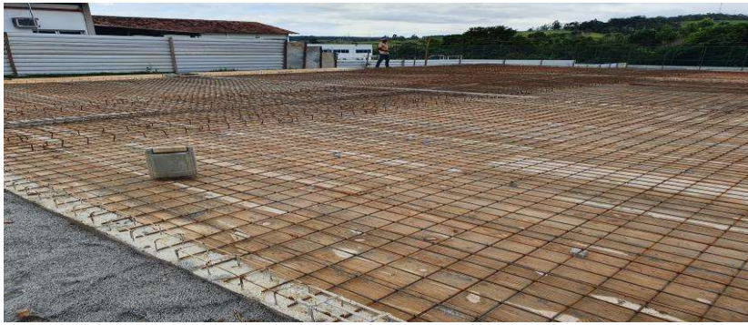
Foto 5: Item 4.1.7: Fôrma de Laje Térreo e Itens 4.1.16 a 4.1.19: Aramadura de Laje;
