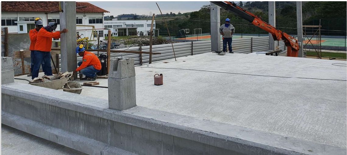
Foto 5: Item 4.2.1 : Estrutura Pré Moldada - Montagem;
