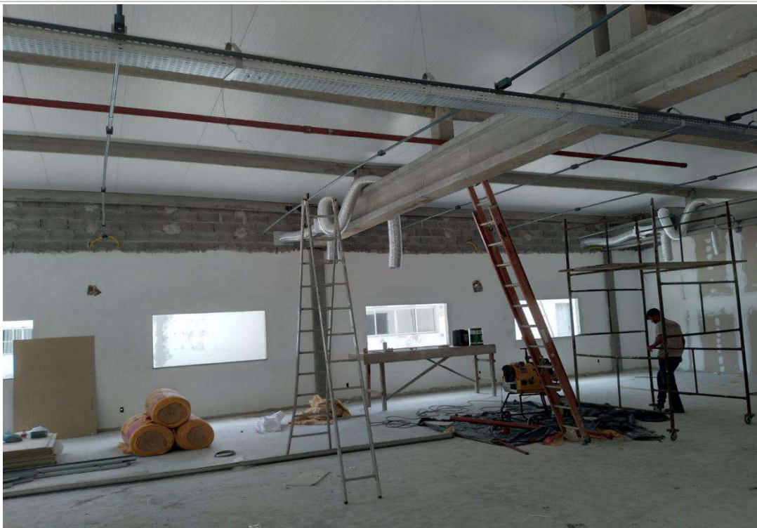
Foto 12: Item 15.2: Caixas de passagem e conexões;
