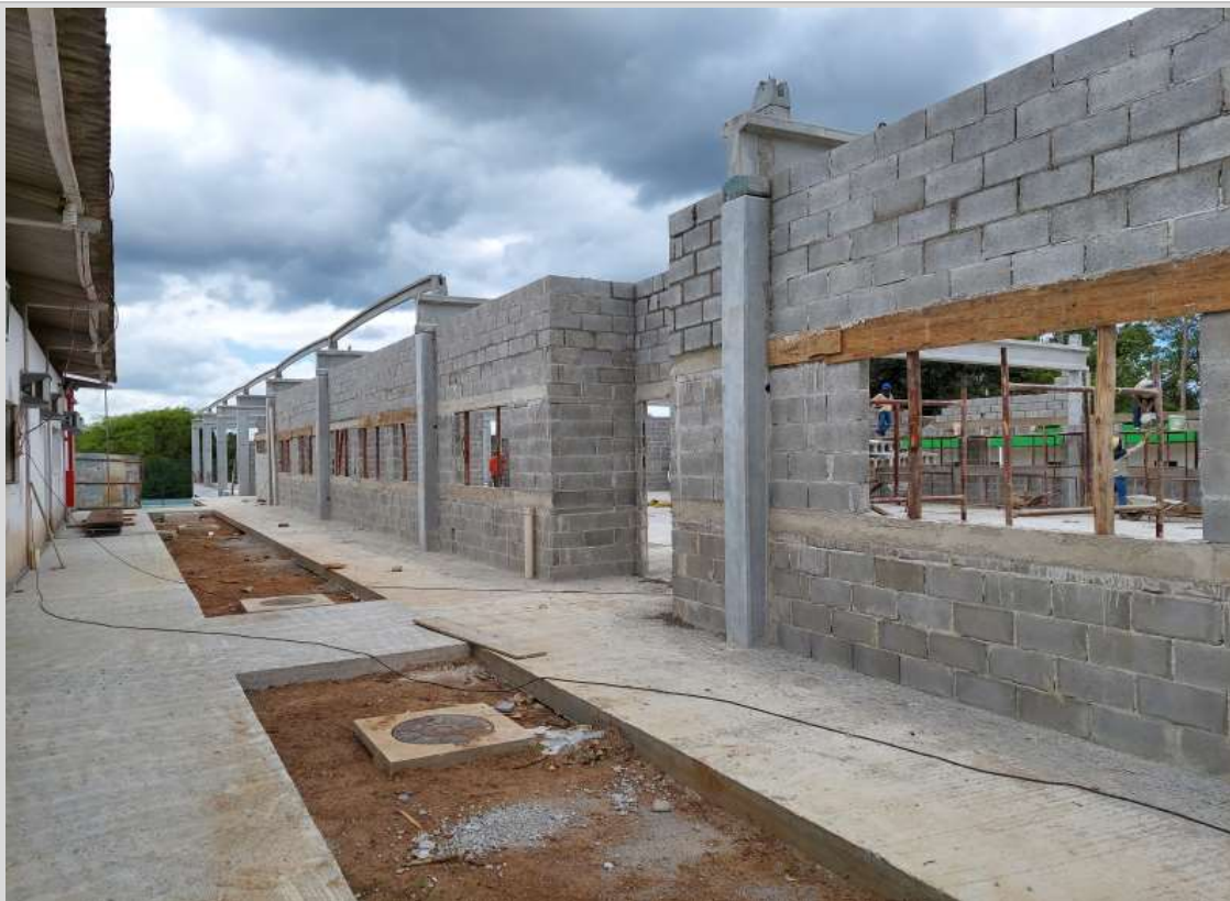
Foto 4: Itens 5.1.1, 5.3.1, 5.3.2, 5.3.3 e 5.3.4: Alvenaria de Blocos e Vergas;
