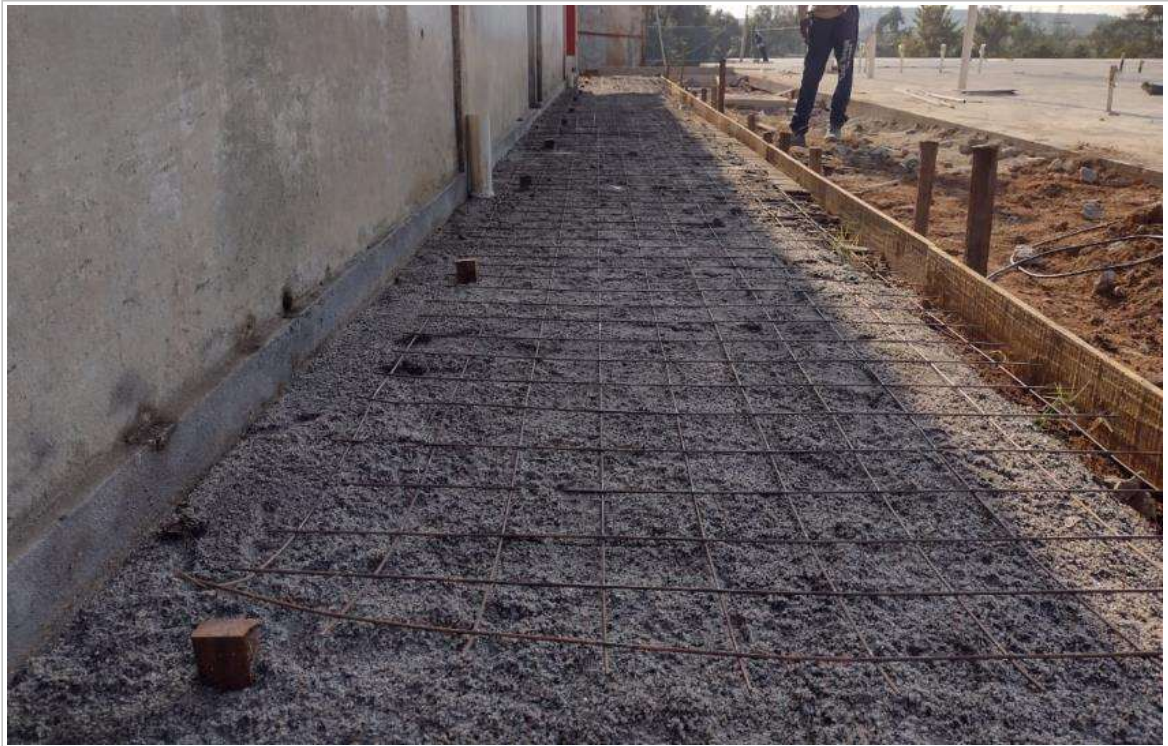
Foto 3: Preparação para concretagem Piso Externo - Aditivo;
