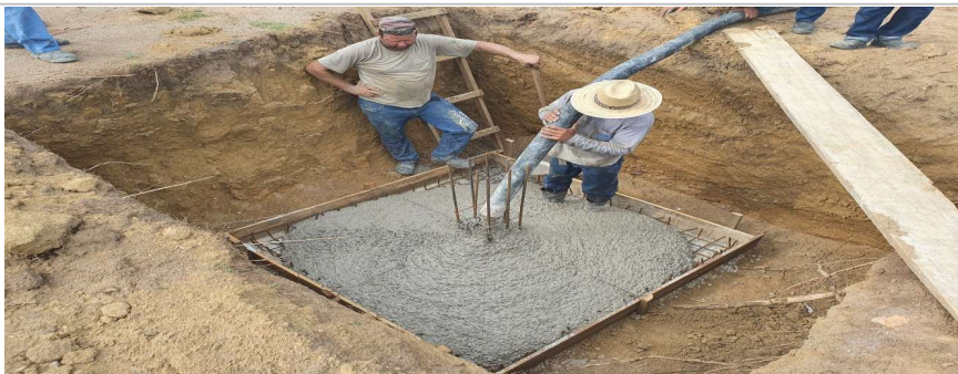
Foto 6: Item 4.1.1: Concretagem de Sapatas
