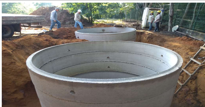
Foto 13: Item 14.6.1: Fossa em anel de concreto pré moldado e Item 14.14.1: Escavação Mecanizada;
