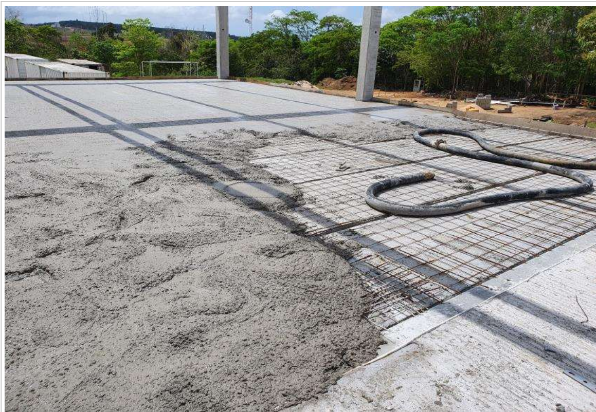
Foto 5: Concretagem Laje Alveolar - Aditivo;
