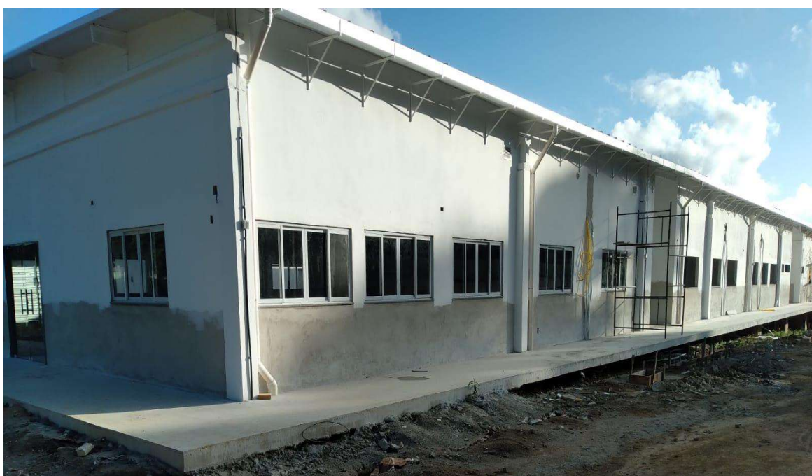
Foto 2: Item 7.2.3: Janelas em Alumínio;
