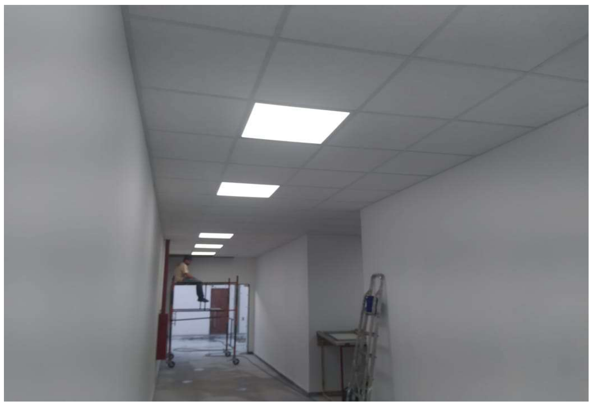
Foto 5: Instalação Forro e luminárias;
