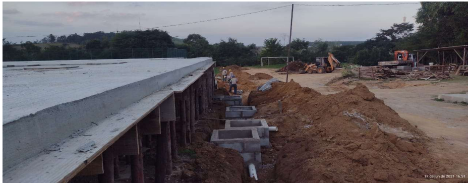
Foto 9: Itens 14.1.5 a 14.1.5: Caixas de Inspeção, Areia, Gordura, Sifonada;
