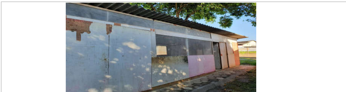
Foto 4: Item 2.2.2: Execução do Refeitório; Item 2.2.3: Execução do Depósito; Item 2.2.4: Execução do Almoxarifado
