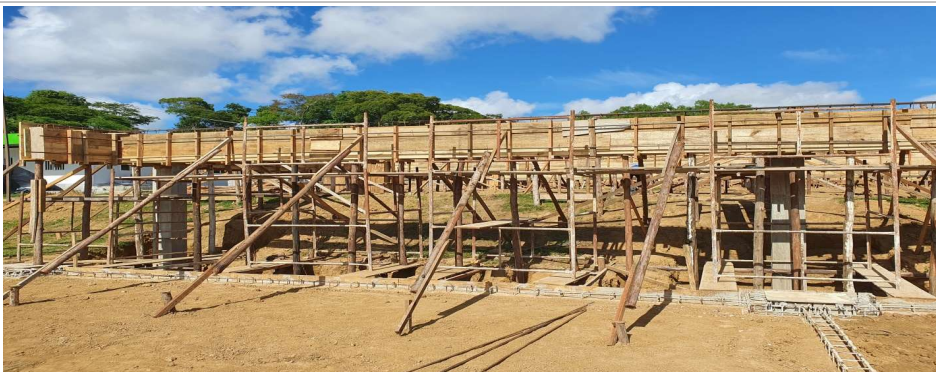
Foto 4: Item 4.1.6: Fôrma de Vigas;
