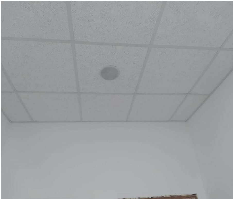
Foto 7: Instalação sistema de som;
