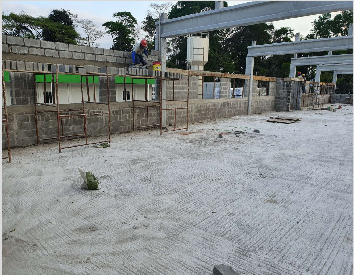
Foto 1: Item 2.1.3 : Montagem de Andaime;
