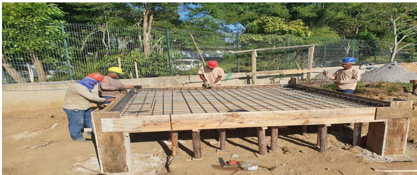
Foto 1: Itens 4.2.4 a 4.2.15, : Estrutura Casa de Bombas e Cisternas;
