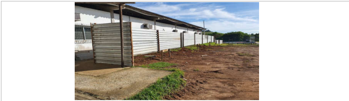
Foto 2: Item 2.1.2: Tapume; Item 3.1.1: Escavação mecânica em campo aberto
