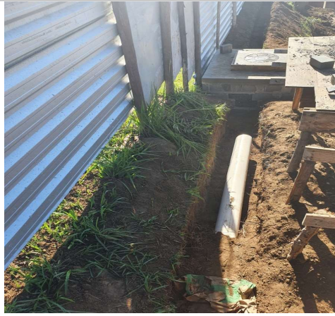
Foto 7: Item 14.4.3: Tubo Esgoto 200mm - Interligação das caixas;
