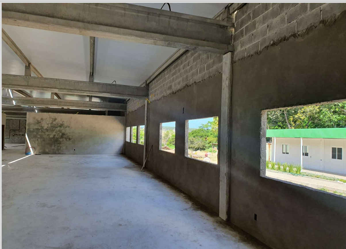
Foto 7: Item 12.1.1: Emboço para recebimento de cerâmica nos WC's;
