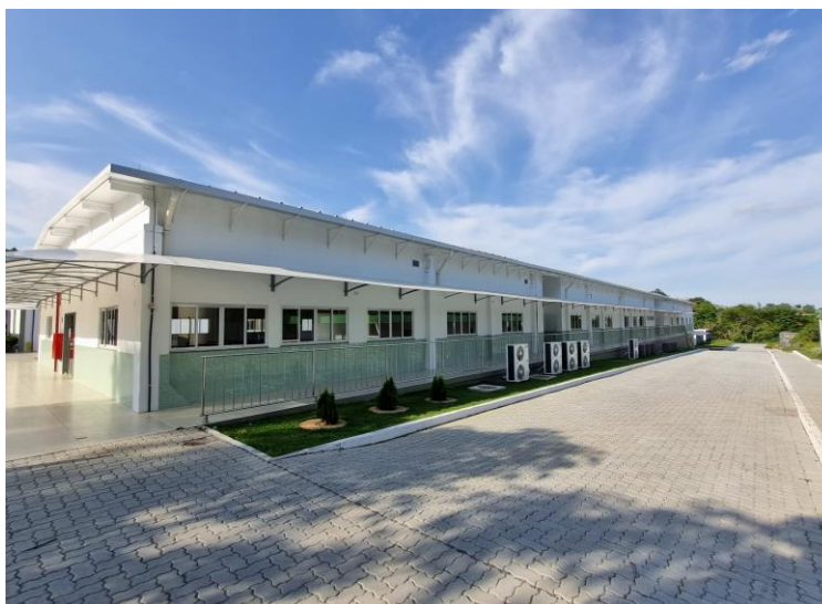
Foto 3: Bloco finalizado - lateral
